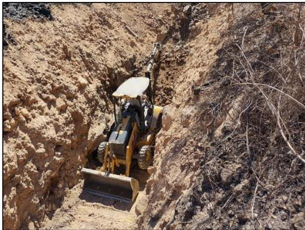
23. Extracción de material edáfico afectado perteneciente a la zanja utilizada para el desplazamiento de las aguas pluviales en tiempos de lluvia.
