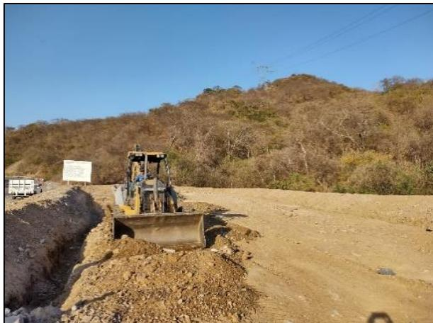
7. Colocación de capa de arcilla en la base de la Celda Provisional.
