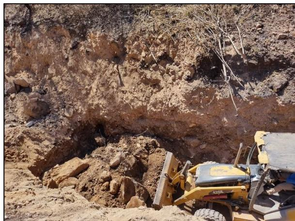
18. Con ayuda de una retroexcavadora, se realizó la extracción del material edáfico afectado.
