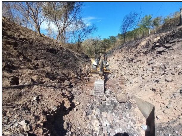
7. Debido a la topografía del sitio y a la presencia de rocas de diferentes tamaños, fue requerida maquinaria pesada para la realización de los sondeos.
