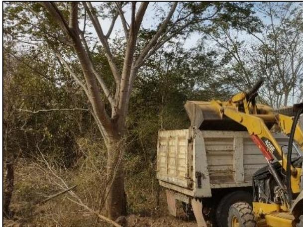
19. Con apoyo de un camión de volteo se acarreó y depositó el material edáfico afectado dentro de la Celda Provisional.
