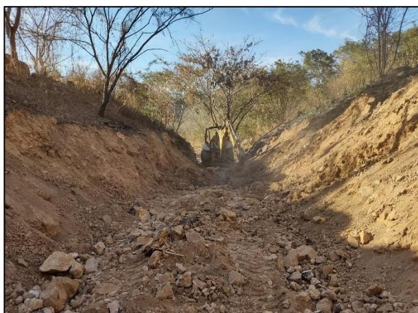
17. Se extrajo el material edáfico afectado de la Fosa de Excavación – Zona II, esto con ayuda de maquinaria pesada.
