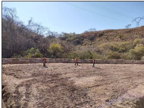
8. Compactación de la capa de arcilla, utilizando un vibro compactador manual.
