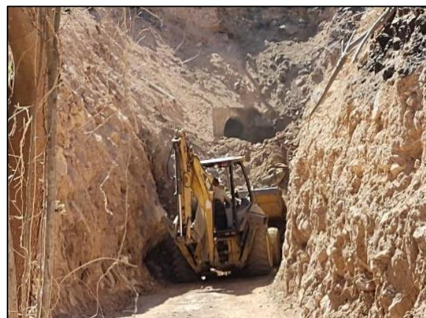
22. Extracción de material edáfico afectado de la Fosa de Excavación – Zona I, donde se encuentra una alcantarilla de concreto.
