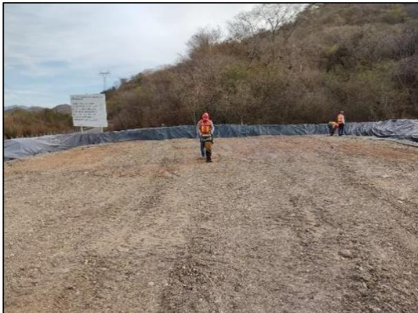
13. Se compactó la segunda capa de arcilla con apoyo de un vibro compactador manual.
