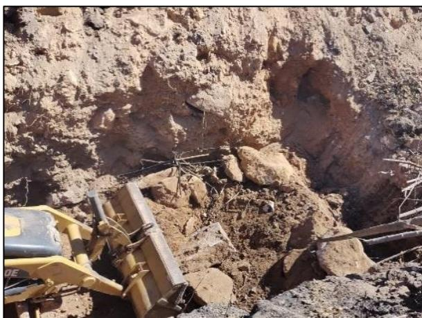
21. Extracción del material edáfico afectado de la Zona I, la cual presenta un suelo de tipo limosa arenosa.
