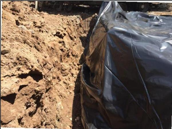
01. El sitio fue debidamente acondicionado para realizar la barrera de contención, así como el recubrimiento de esta con película de alta densidad.
