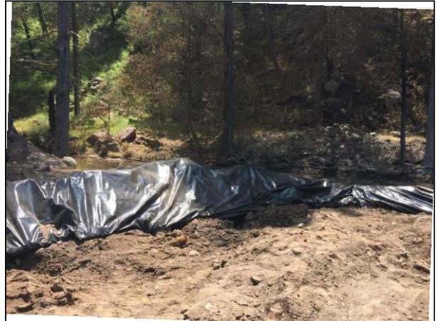
02. La barrera de contención se realizó para evitar el desplazamiento del hidrocarburo, así como para evitar la afectación del arroyo intermitente innominado que se encuentra cerca del sitio afectado.
