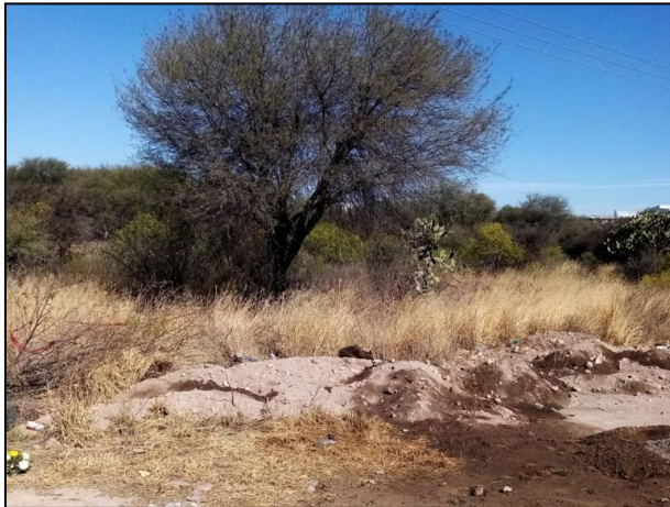
02. Vista del sitio en estudio, en la que se observa la presencia de bordos de contención, realizados como labor de emergencia por cuerpos de rescate al momento del derrame.
