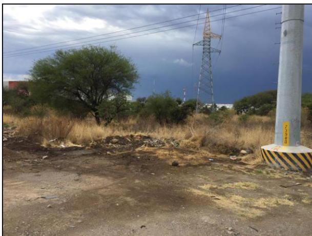
04. El Diésel derramado se desplazó alrededor de poste troncocónico propiedad de la Comisión Federal de Electricidad (CFE)
