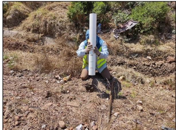
4 - Instalación de la tubería de PVC dentro del Área Afectada.
