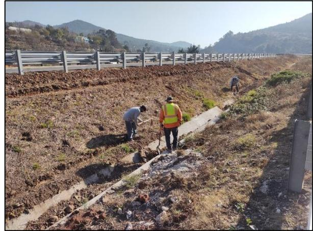
2 - Personal de campo, equipado con palas y picos, procedió a realizar una zanja en los perímetros del Área Afectada y limpieza de canaleta.
