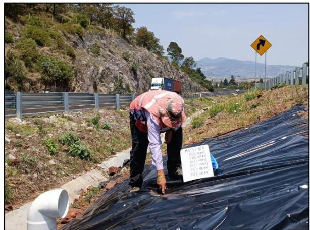
04. Se realizaron cortes en la película de polietileno de alta densidad para la toma de muestras dentro del Área Afectada.
