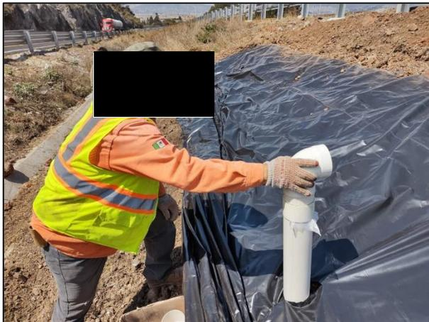
9 – Instalación de los filtros de carbón activado.
