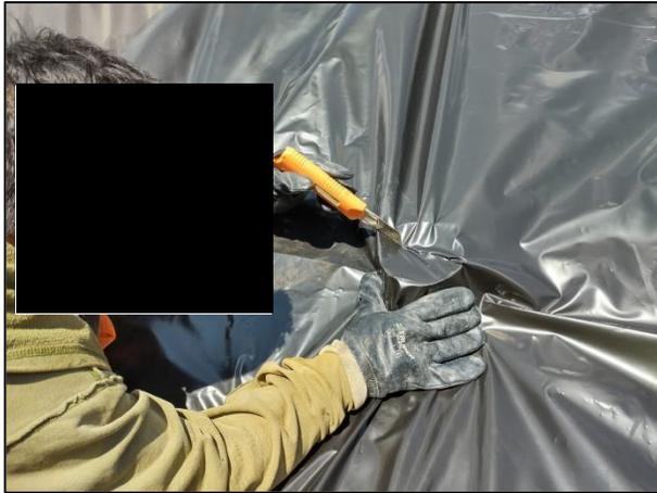
7 – Realización de incisiones de la película de polietileno de alta densidad para la instalación de los filtros de carbón activado.
