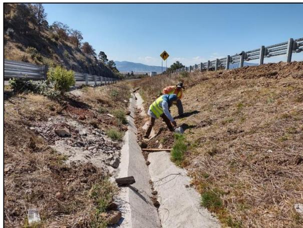
5 – Se realizó la limpieza de la canaleta de concreto. El material azolvado fue colocado en el Área Afectada encontrada a un lado de dicha canaleta.
