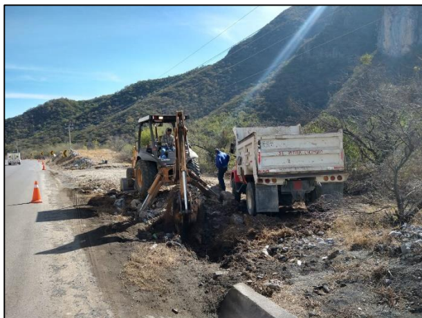
11 - Posteriormente, con ayuda de retroexcavadora se realizó la extracción del material edáfico afectado con Diésel.
