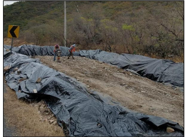
10 - Con apoyo de una compactadora manual, se realizó la compactación de la segunda capa de arcilla.
