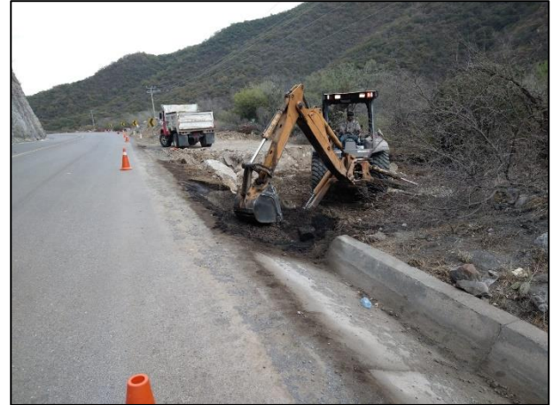
14 - Labor de extracción del material edáfico afectado con Diésel de la Zona afectada.
