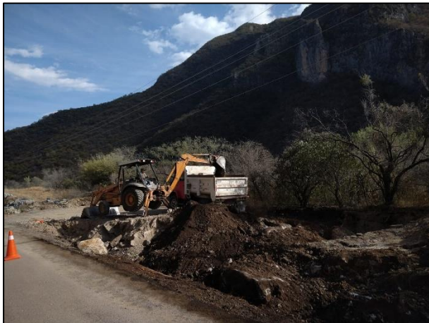
15 - Colocación del material edáfico afectado en camión de volteo para su acarreo hacia la Celda Provisional.
