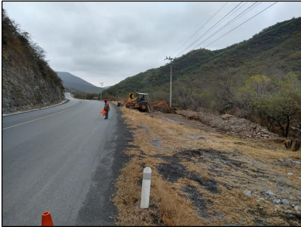
01 - Por seguridad, el sitio en estudio fue señalado con equipo de seguridad vial, delimitando a su vez el área de trabajo.
