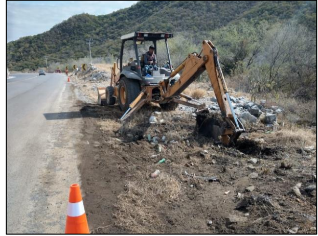
04 - En el suelo afectado y en su periferia se llevaron a cabo sondeos con el objetivo de conocer la infiltración y delimitación de la Zona. Algunos sondeos se realizaron con retroexcavadora debido a la presencia de roca.
