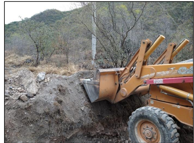
04 - Compactación de los bordos perimetrales.
