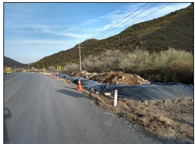
18 - Celda Provisional construida y en la cual se colocó el material edáfico afectado con Diésel.
