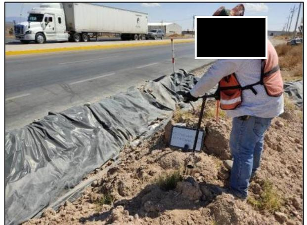
09. Con el apoyo de un Hand auger de acero inoxidable, se tomó la muestra en la Celda Temporal.
