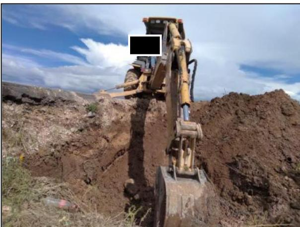
11. Extracción del material edáfico afectado con apoyo de retroexcavadora.
