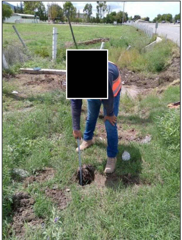
08. Se realizaron sondeos fuera del área afectada, a fin de corroborar la extensión de la pluma del contaminante.
