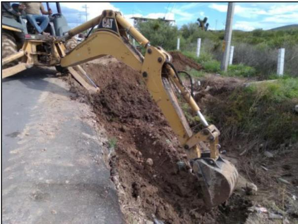
09. Extracción del material edáfico afectado con apoyo de retroexcavadora.
