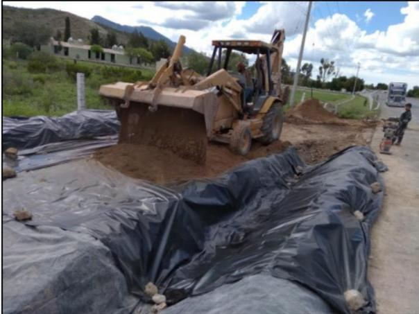
07. Depósito de segunda capa de arcilla sobre película de polietileno de alta densidad
