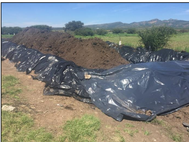
17 - Colocación completa del material edáfico afectado dentro de la Celda Provisional.
