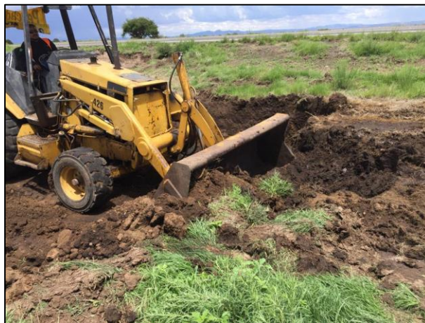
10 - Con ayuda de retroexcavadora, se realizó la extracción del material edáfico afectado en el sitio de derrame.
