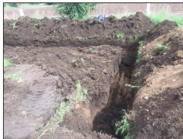
04 - Construcción de canaletas para la captación de lixiviados.
