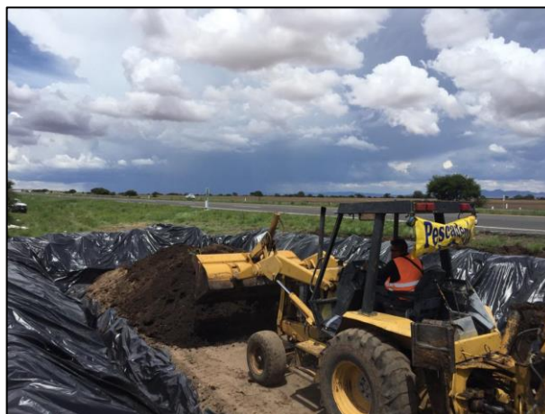
12 - El material edáfico extraído fue depositado en la Celda Provisional.
