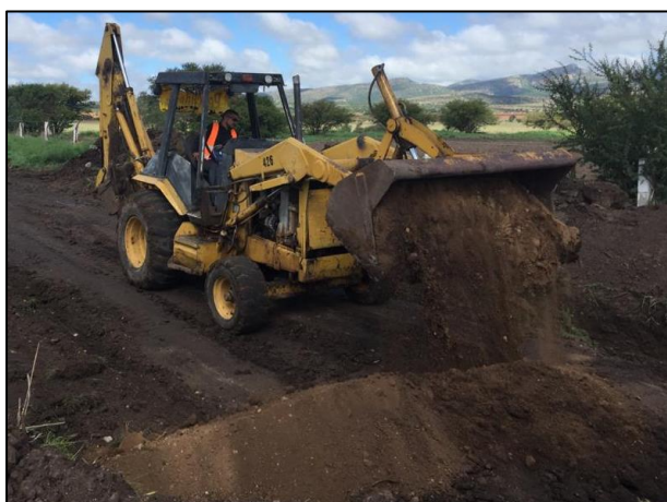
05 - Con apoyo de retroexcavadora se colocó una capa de arcilla en la base de la Celda Provisional.
