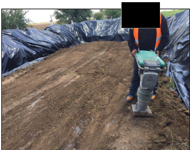
09 - Con apoyo de recurso humano y de una compactadora manual, se realizó la compactación de la capa de arcilla.
