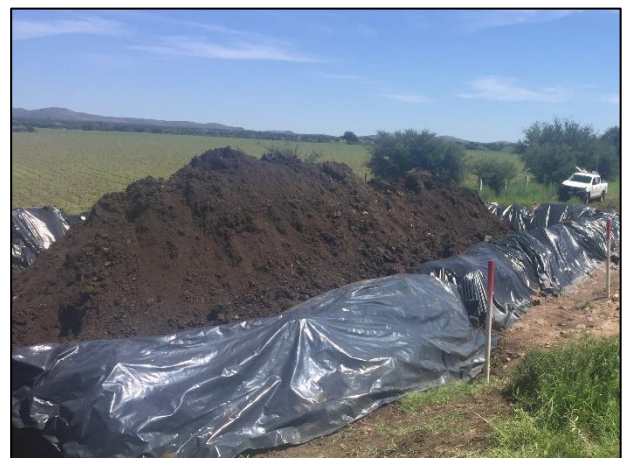
18 - Celda Provisional construida y en la cual se encuentra colocado el material edáfico afectado.
