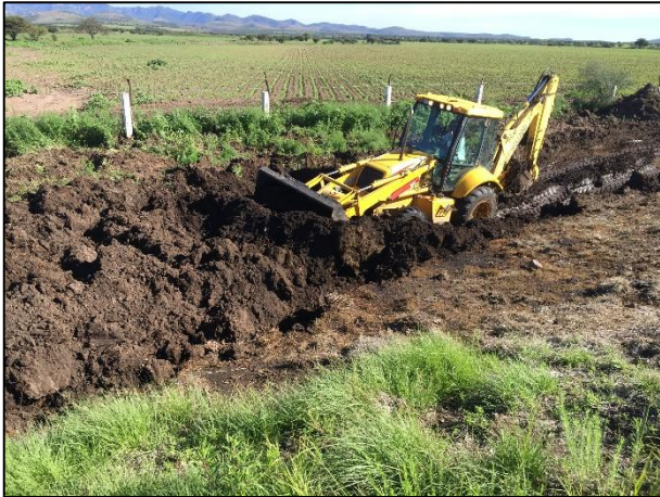
13 - Extracción del material edáfico afectado a la altura del Km. 069 + 000 de la Autopista Torreón – Durango (tramo Durango – Yerbanis), municipio de Guadalupe Victoria, estado de Durango.
