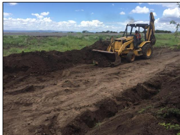
02 - Acondicionamiento del terreno designado para la construcción de la Celda Provisional.
