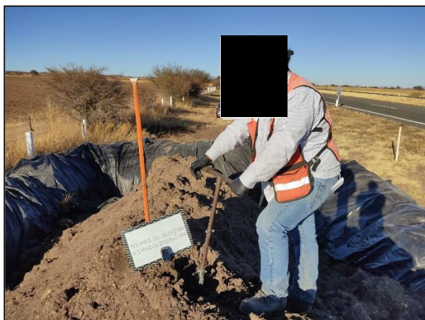
11 - Toma de muestra dentro de la Celda Provisional.
