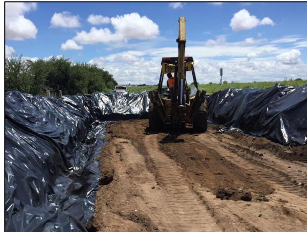
08 - Colocación de segunda capa de arcilla.
