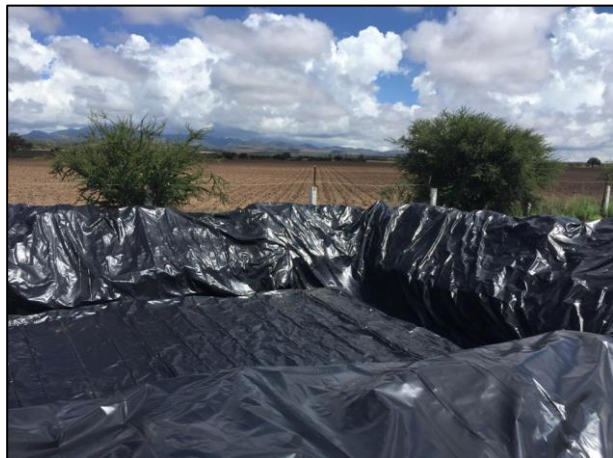
07 - La Celda Provisional se cubrió con una membrana de polietileno de alta densidad.
