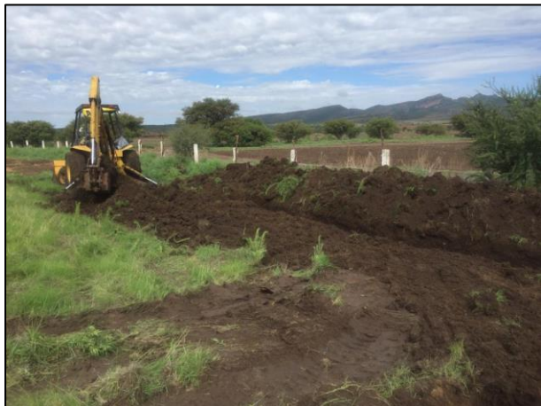
01 - Con ayuda de maquinaria pesada como lo es la retroexcavadora, se dio el acondicionamiento al sitio designado para la construcción de la Celda Provisional.
