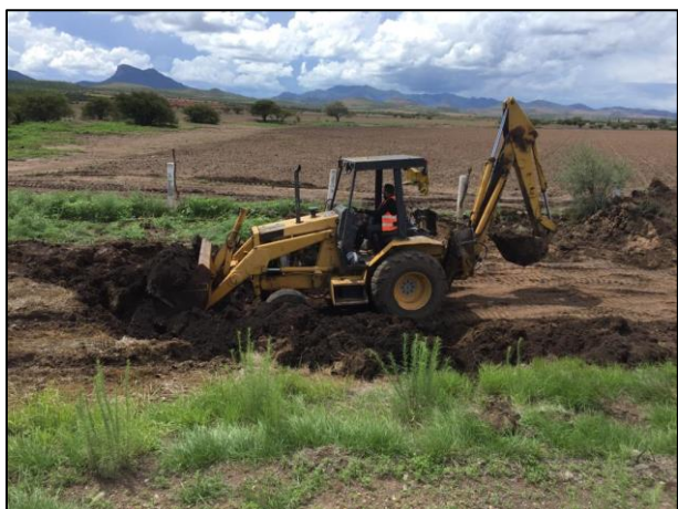
11 - Labor de extracción del material edáfico afectado por el derrame de Diésel.
