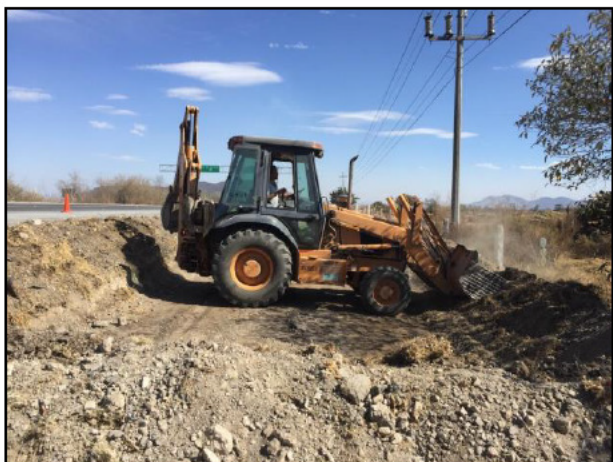
3. Se procedió a la construcción de los bordos de la Celda, con material libre de contaminantes.
