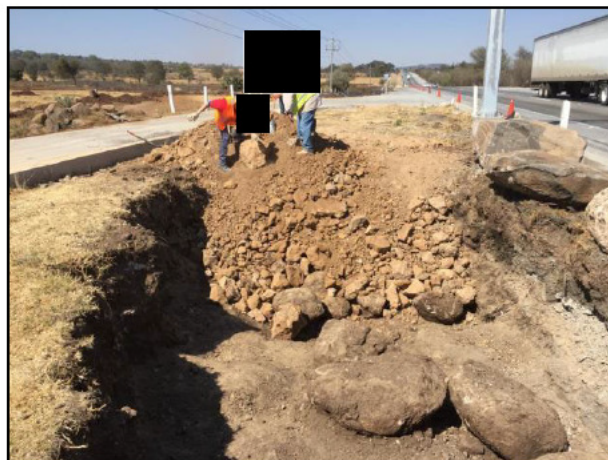
20. La distribución del material de relleno se realizó con apoyo de recurso humano y herramienta manual.
