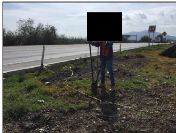
4. Se realizaron pozos de sondeo para conocer la infiltración del contaminante.
