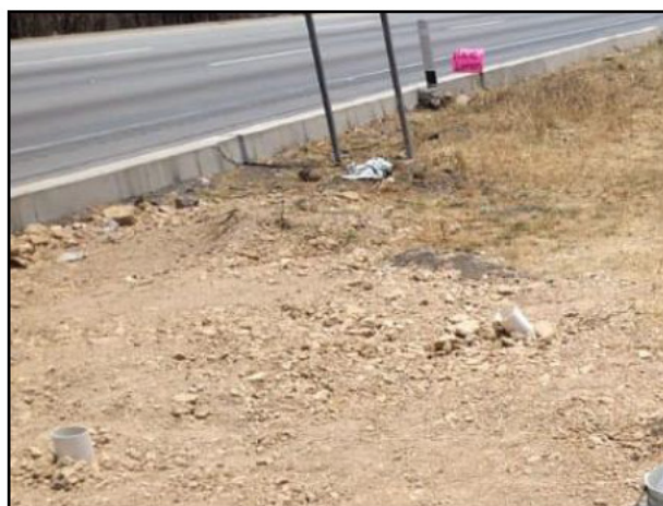
22. La Fosa de Excavación A fue rellena con material edáfico, así mismo, se colocaron los tubos de monitoreo.
