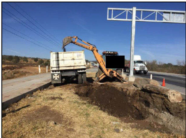
13. Con apoyo de retroexcavadora, se extrajo el material edáfico, colocándolo seguidamente en camión de volteo.
