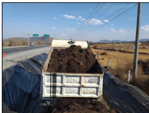
17. Material edáfico afectado colocado en la Celda Provisional.
