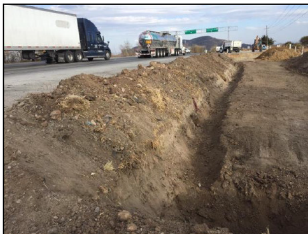
4. Construcción de canaletas para captación de lixiviados.
