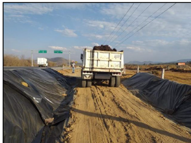
14. El material edáfico extraído fue acarreado a la Celda Provisional con apoyo de un camión volteo.
