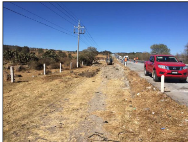
2. Acondicionamiento del terreno para la construcción de la Celda Provisional.
