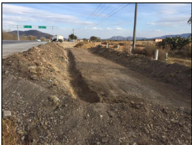
5. A la Celda Provisional se le construyeron los bordos, así como también las canaletas para la captación de lixiviados.
