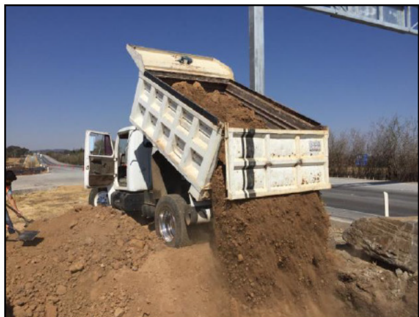
19. Se procedió al relleno de la Fosa de Excavación A con material edáfico libre de contaminantes.
