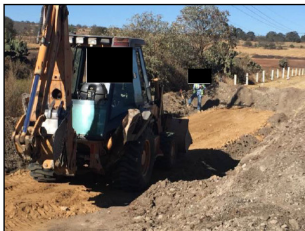
6. Con apoyo de retroexcavadora se colocó una capa de arcilla en la base de la Celda Provisional.
