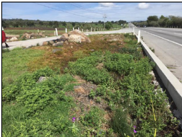
1. El punto de impacto se encuentra en el Km. 096 + 500 de la Carretera (1720) México – Querétaro, tramo México – Querétaro, municipio de Soyaniquilpan de Juárez, Edo. de México.
