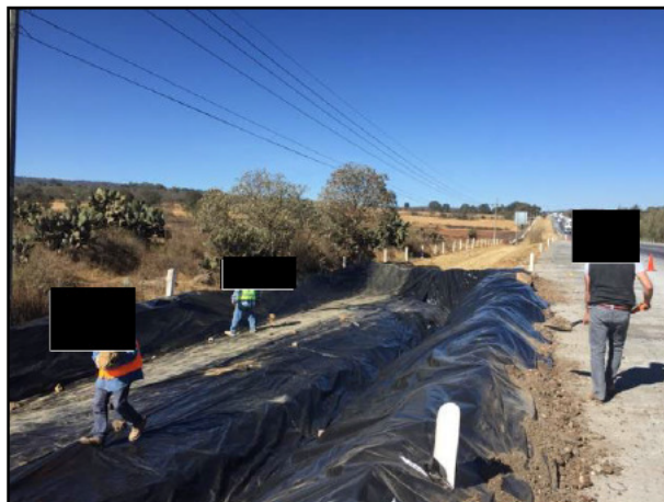
8. Celda Provisional cubierta con película de polietileno de alta densidad.
