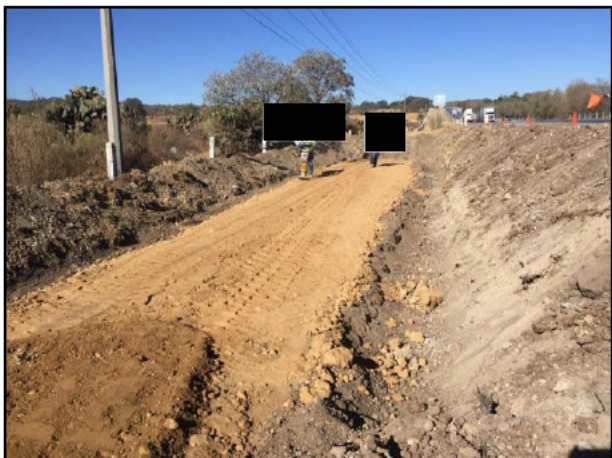
7. Compactación de la capa de arcilla, utilizando un vbro compactador manual.
