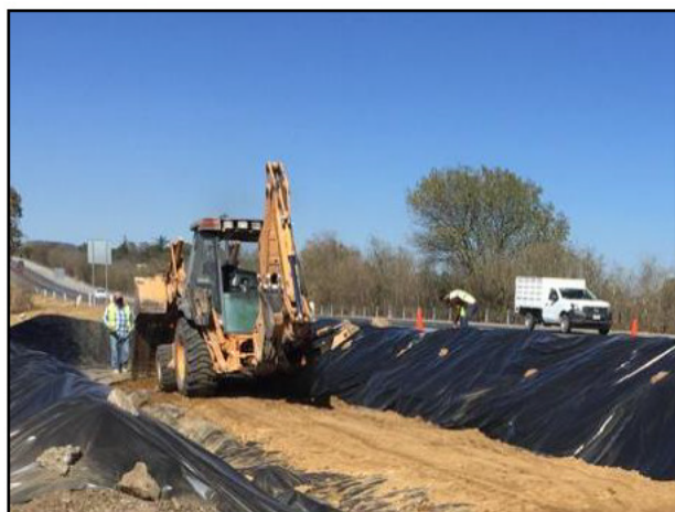
9. Colocación de segunda capa de arcilla con apoyo de retroexcavadora.
