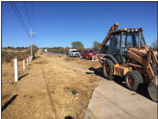
1. Por seguridad, se colocó la correcta señalización preventiva en el área de trabajo, así mismo, se presentó personal de TELMEX para ubicar la fibra óptica.
