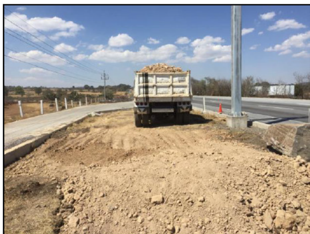
21. Con apoyo de camión volteo se procedió al relleno de la Fosa de Excavación A.
