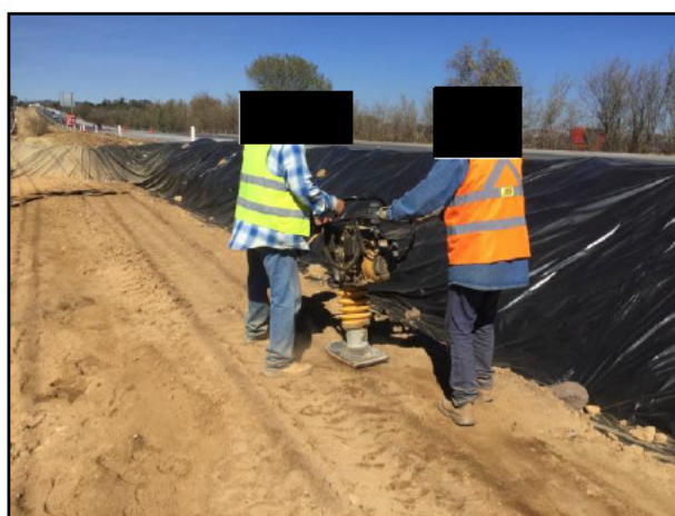
10. Con apoyo de recurso humano y de un vbro compactador manual, se realizó la compactación de la capa de arcilla.
