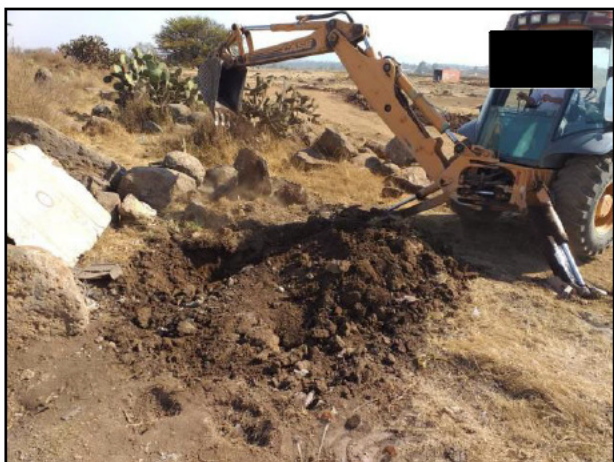
15. Se procedió a la extracción del material edáfico en el derecho de vía.
