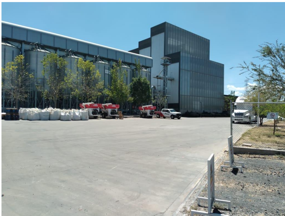
Presencia de plancha de concreto, sin vegetación y fauna nativa de las áreas colindantes donde se instalará la “Estación de Descompresión NOVASEM”
