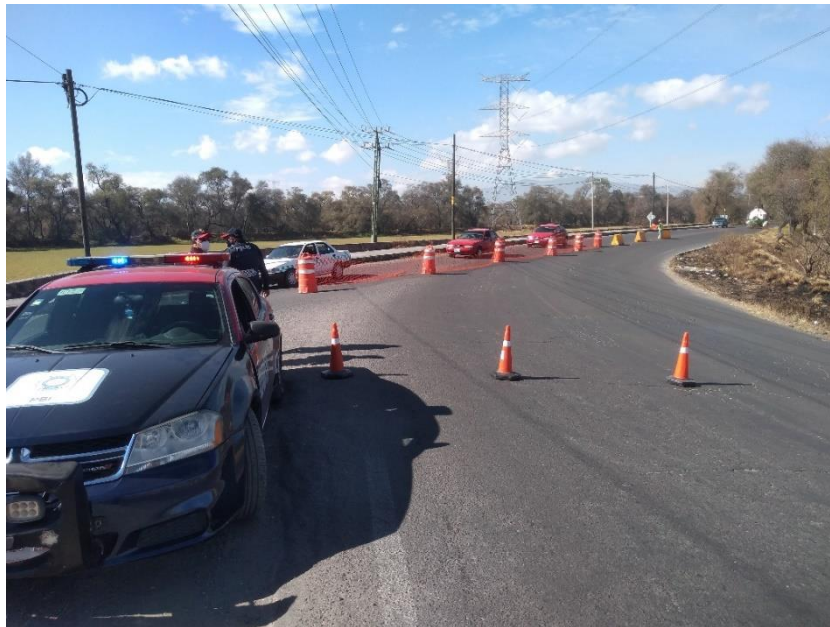
Figura II.7. Colocación de señalamientos y control de tráfico en el frente de la obra.
