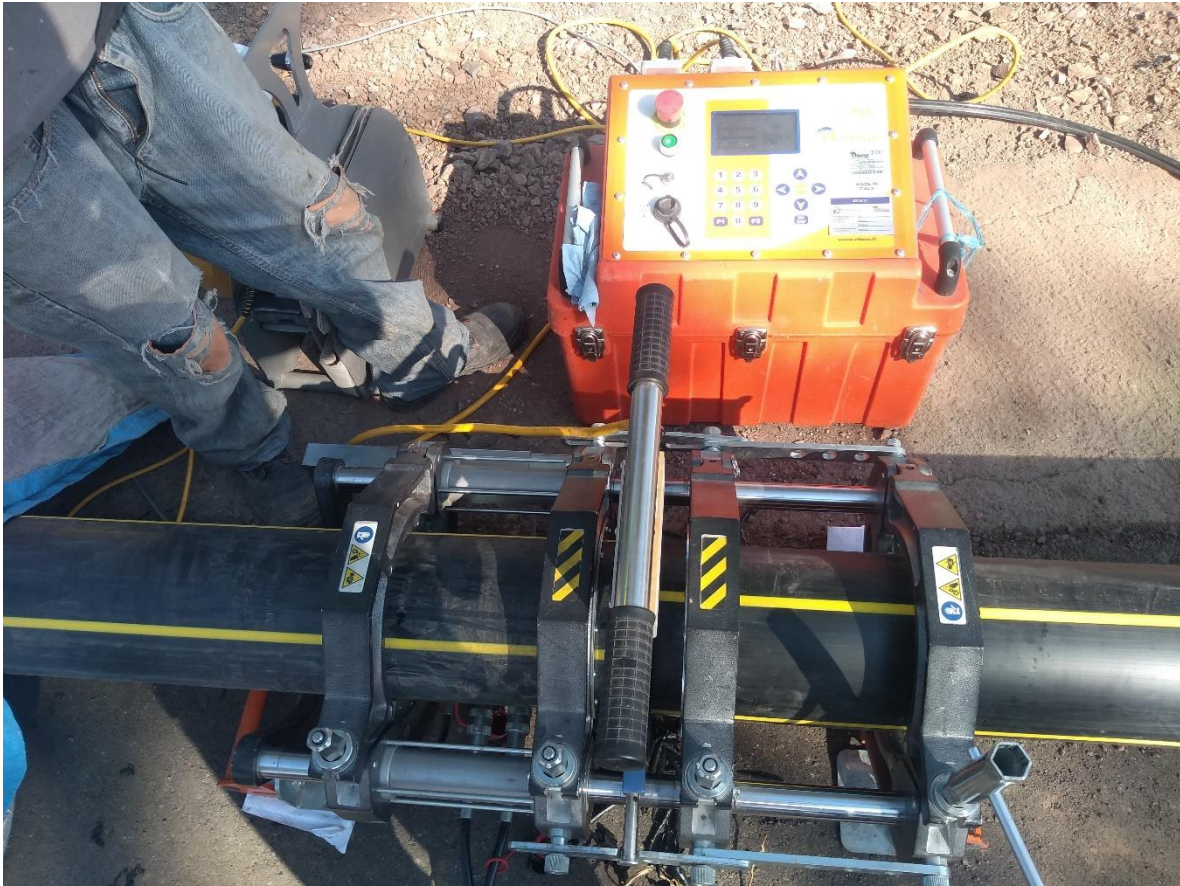
Figura II.25. Proceso de termosoldado de tubería de polietileno.
