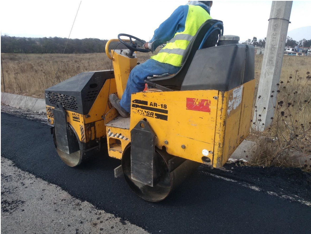
Figura II.28. Reposición de carpeta asfáltica.
