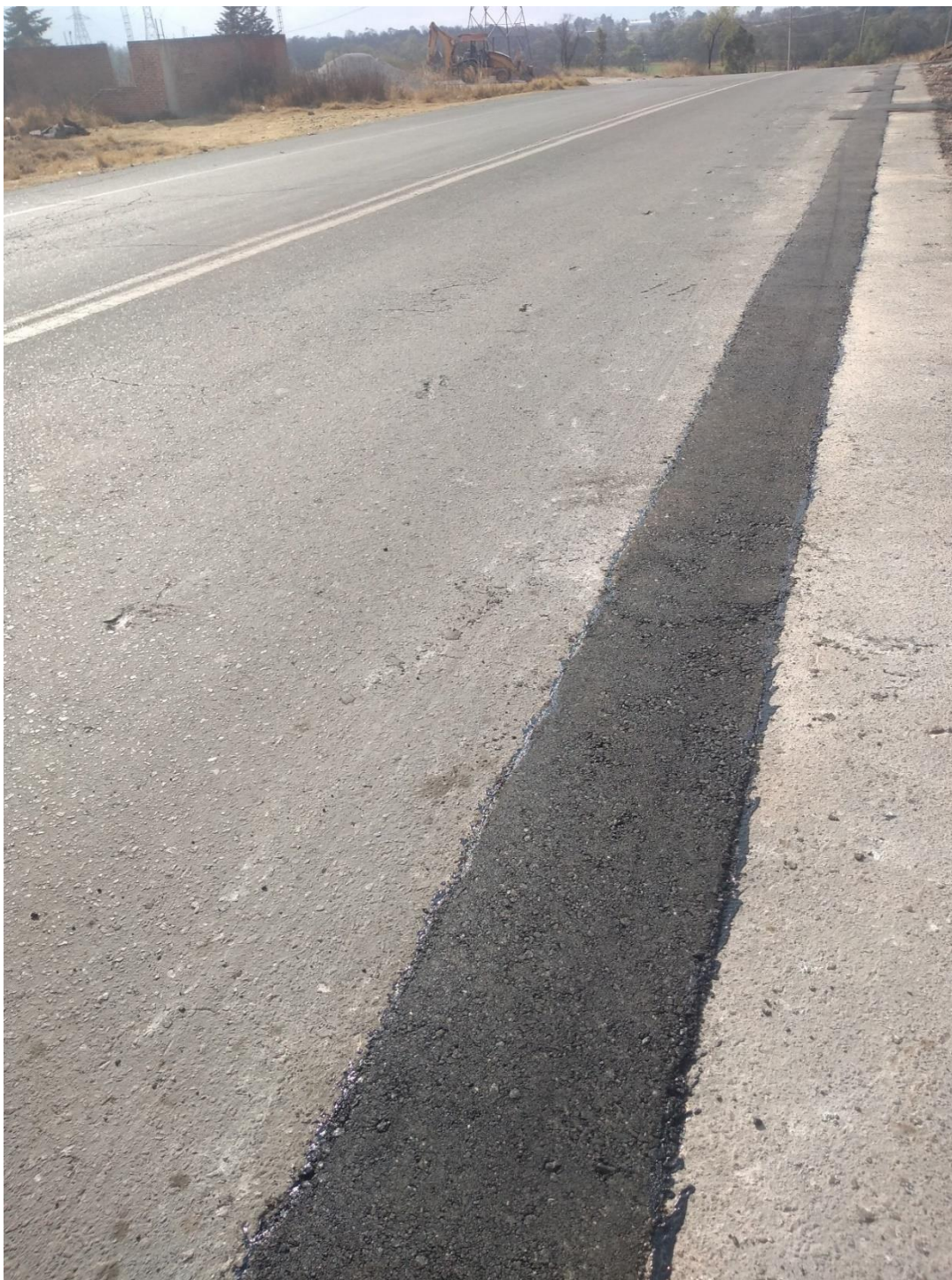
Figura II.29.Limpieza y acabado final de la instalación del ducto en el frente de la obra.
