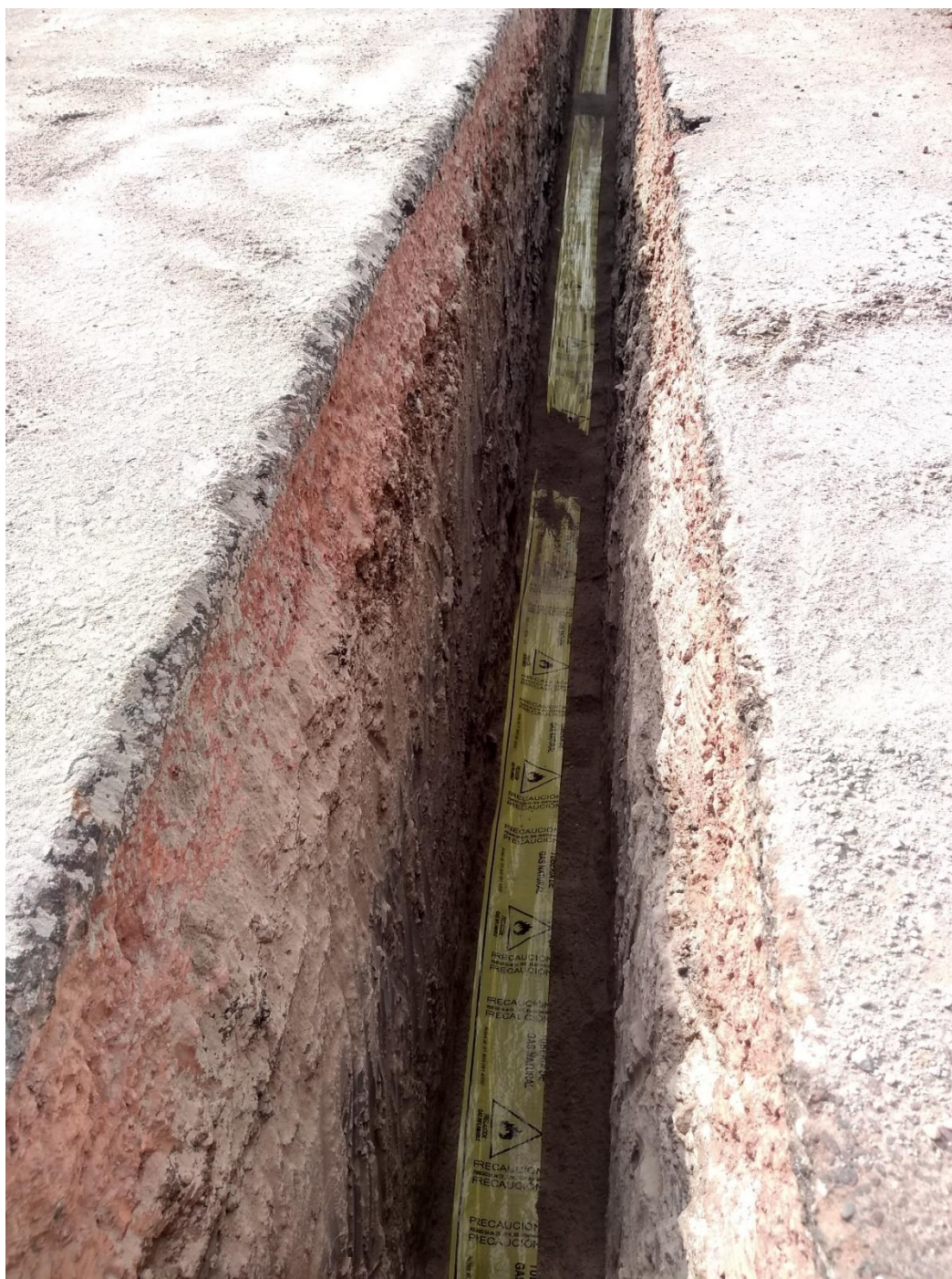
Figura II.26. Primera capa de recubrimiento de la tubería instalada.
