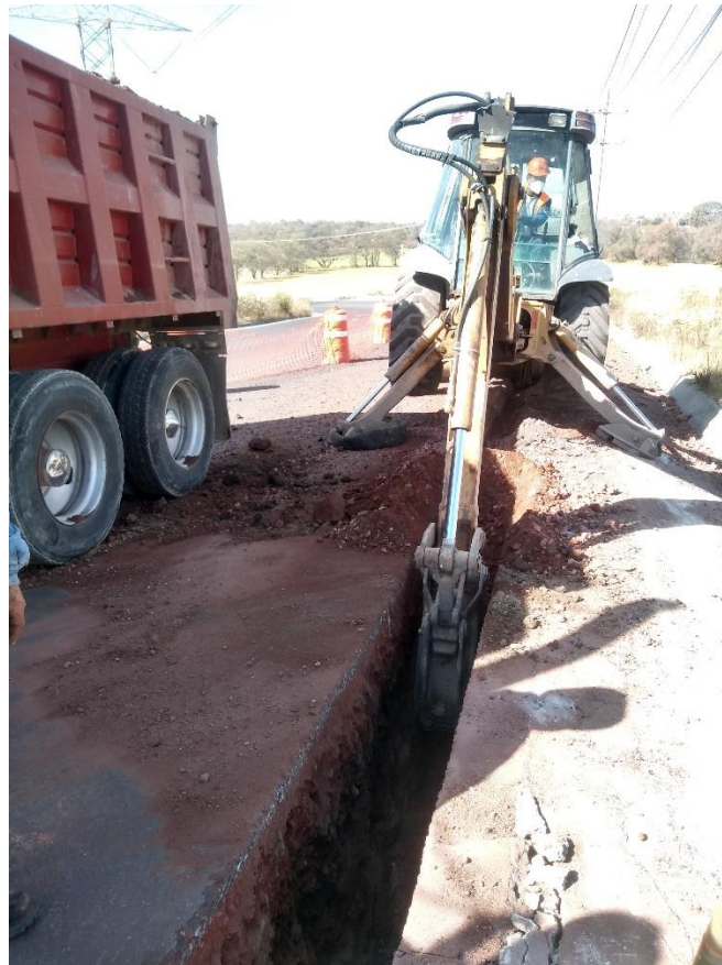
Figura II.8. Excavación y apertura de la zanja.
