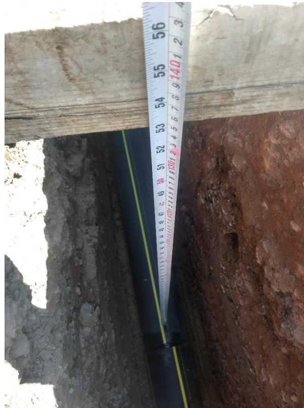
Figura II.10. Verificación de la profundidad de la zanja.
