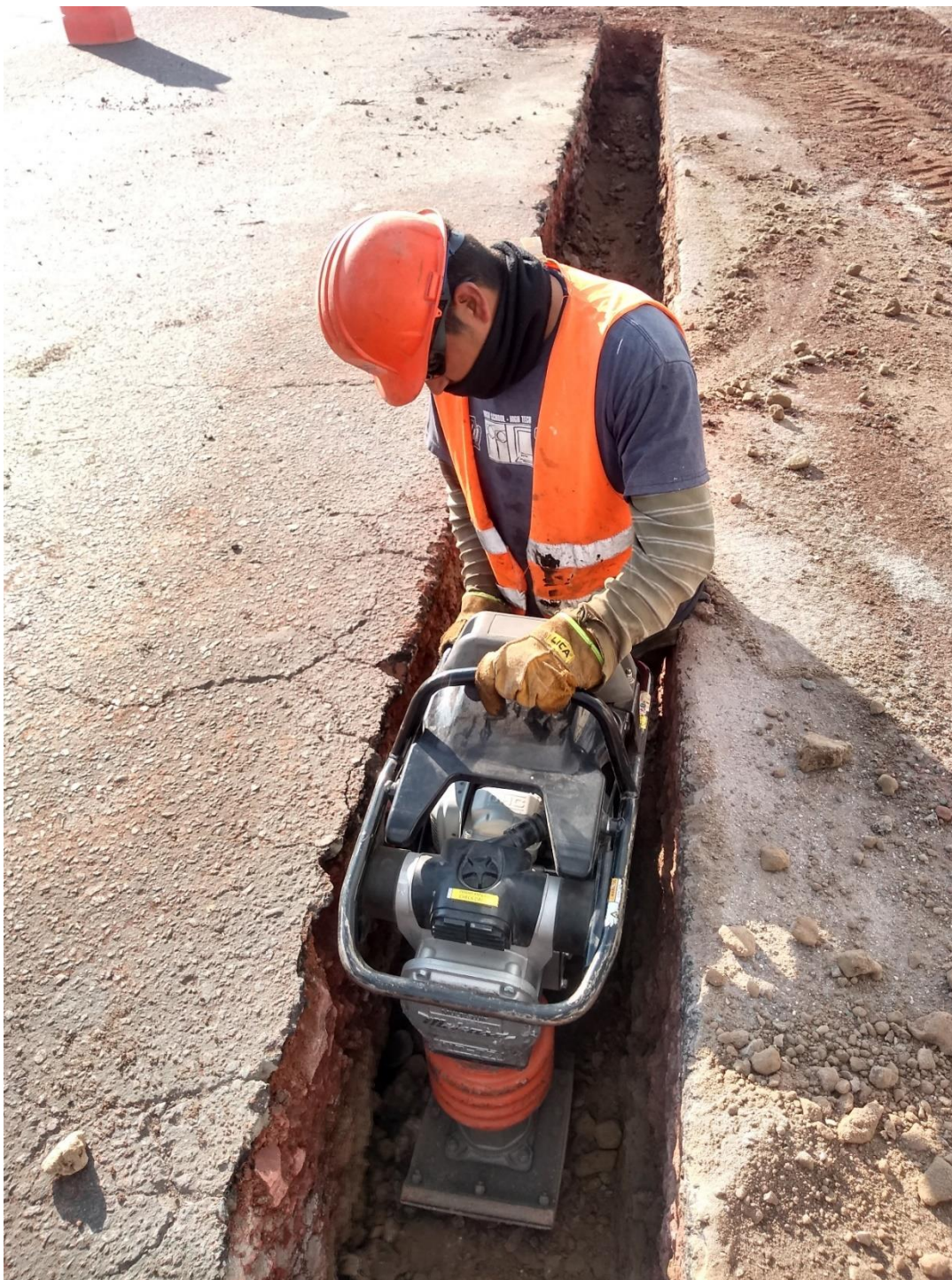
Figura II.27. Compactación del relleno de la zanja.
