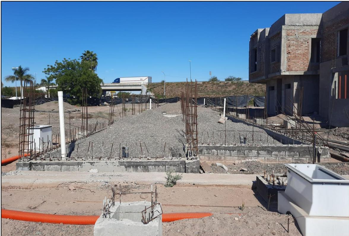
Fotografía 4. Avance de obra actual en zona de tanques de almacenamiento
