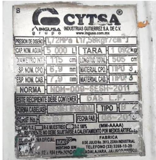
**Figura II.1.** Placa de identificación del tanque de almacenamiento.
