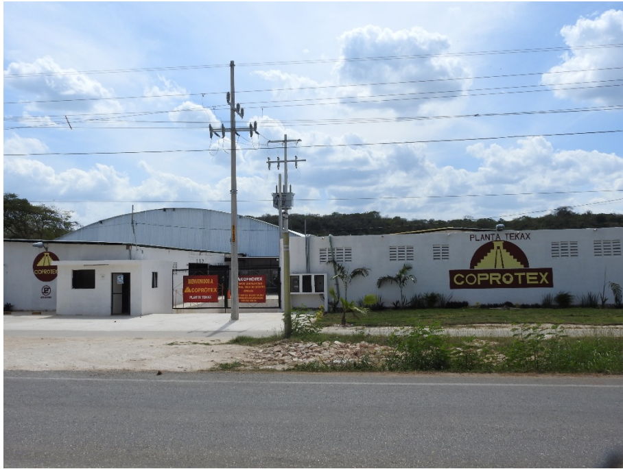
C7.-Vista hacia el sur, se observa las instalaciones de la maquiladora COPROTEX planta Tekax.
