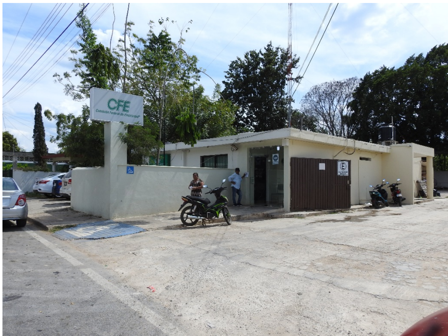
G18.-Vista hacia el sur, se observa un modulo de oficinas administrativas de la CFE, Tekax.
