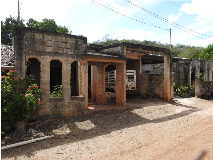
D10.-Vista hacia el oeste, se observa casa habitación y líneas de distribución de energía eléctrica de la CFE.
