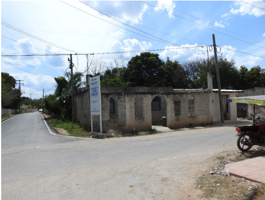
F15.-Vista hacia el norte, se observa casa habitación y la calle 22 x 51 de Tekax.
