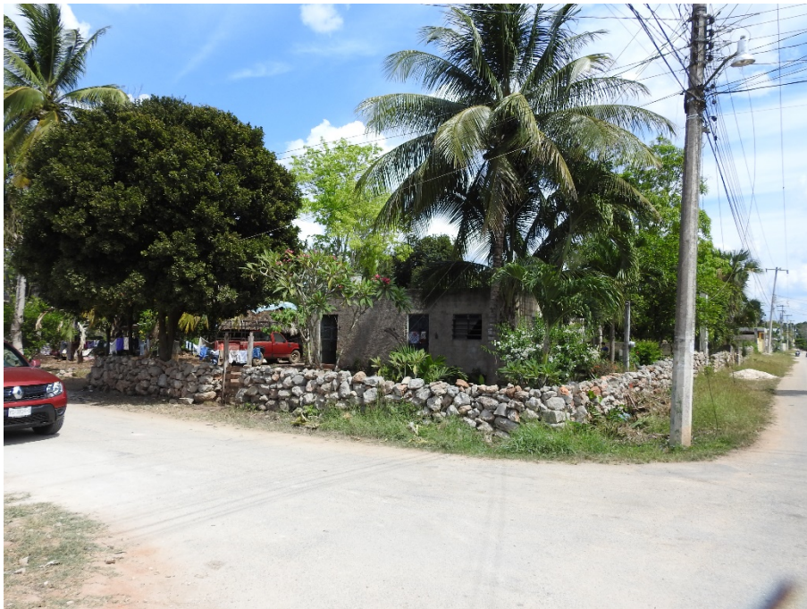
F16.-Vista hacia el este, se observa casa habitación, líneas de distribución de energía de la CFE.
