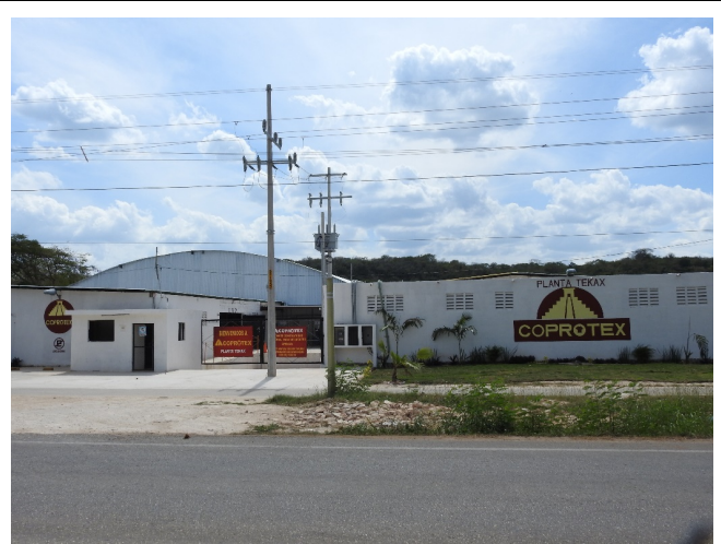
Vista hacia el sureste del SA, se observa las instalaciones de la maquiladora COPROTEX planta Tekax.
