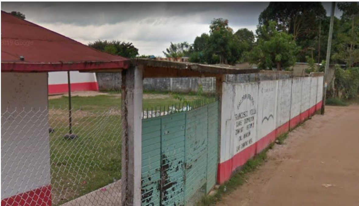
Fotografía 7. Primaria Francisco Villa.
