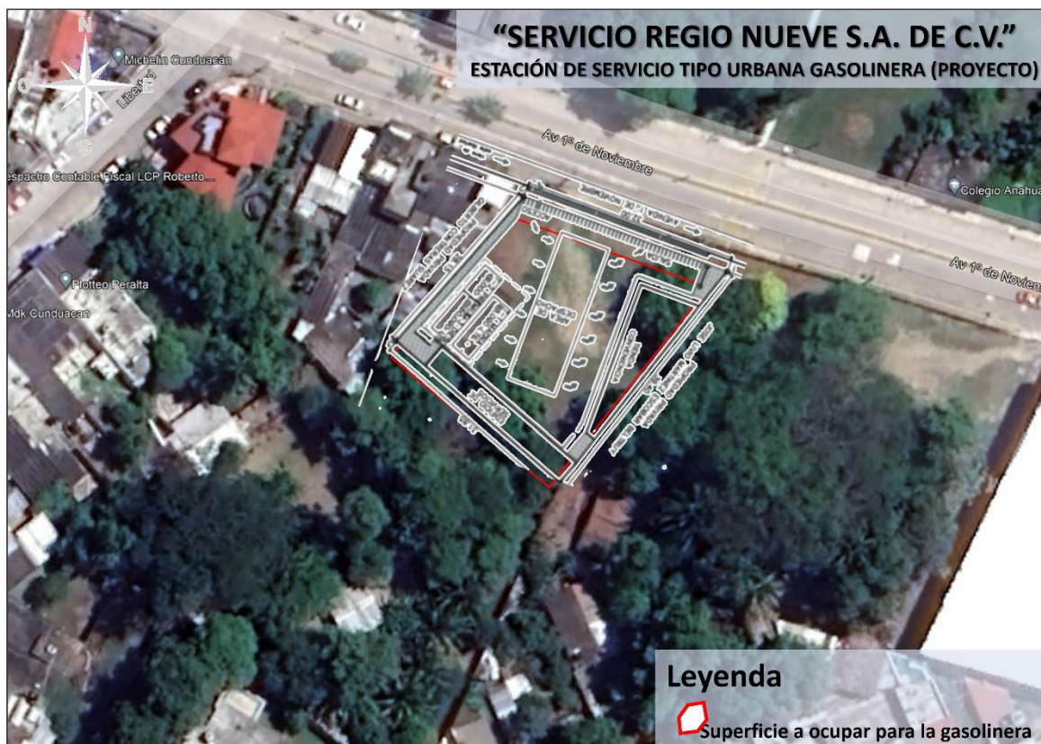
Figura III. 1.- Vía de acceso.
