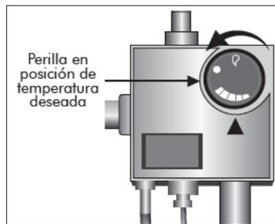
Suelte el botón de paso del gas hacia el piloto. La llama del piloto debe permanecer encendida. En caso contrario repita los pasos C y D, conservando oprimido el botón de paso del gas hacia el piloto durante más tiempo.
