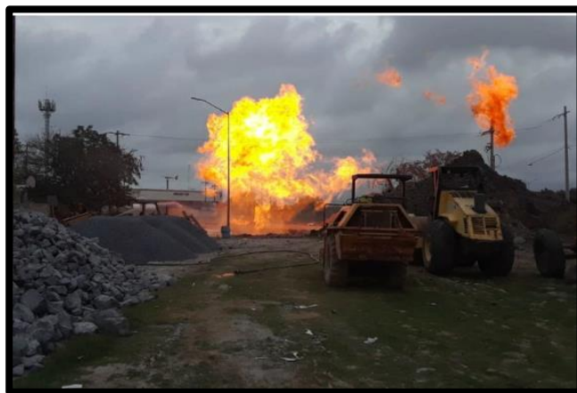
Foto 4. Explosión causada por maquinaria.
