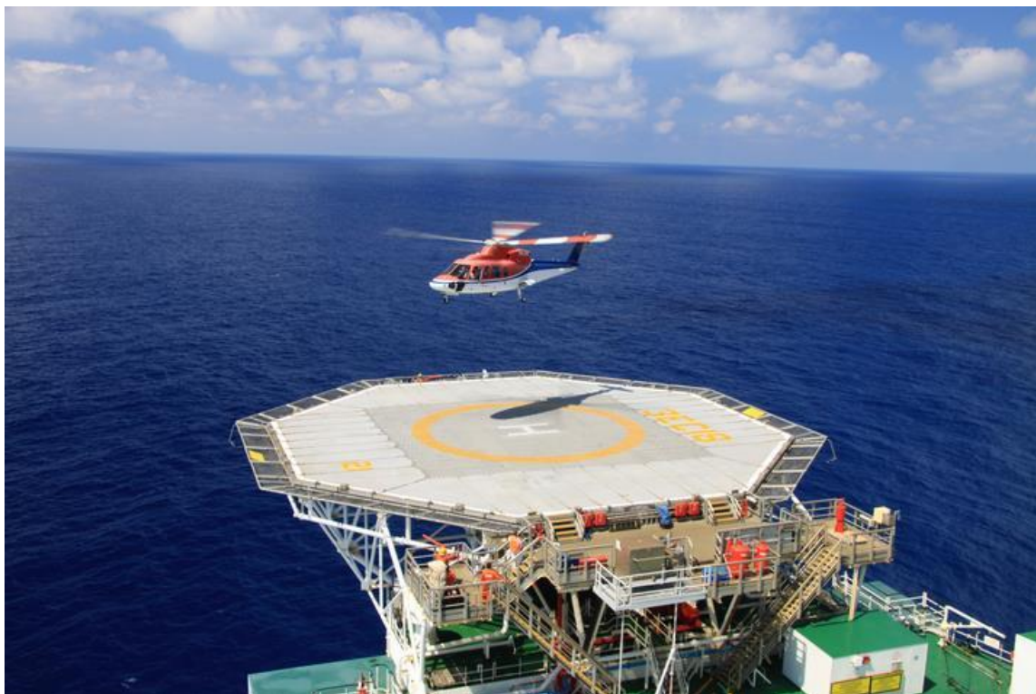
Imagen 2-3 Helipuerto Costa Afuera
