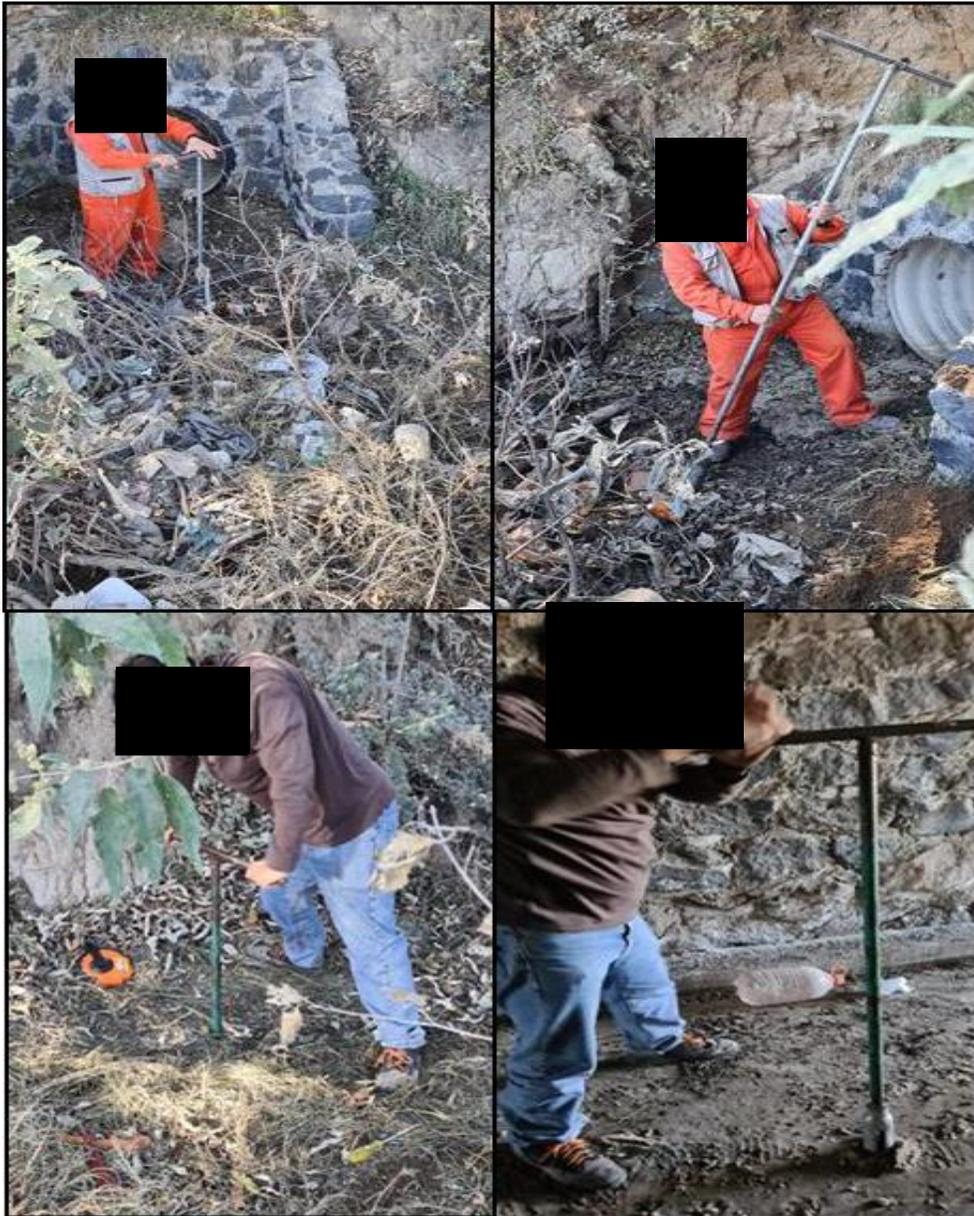
**Fotografía 5.-** Perforación de Pozos para sondeos de identificación de zona contaminada en visita inicial.
