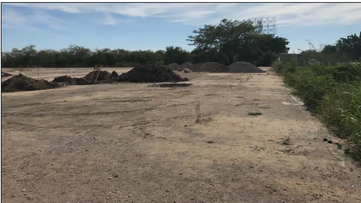
Fotografía 16.- Vista actual del terreno del proyecto nivelado y compactado
