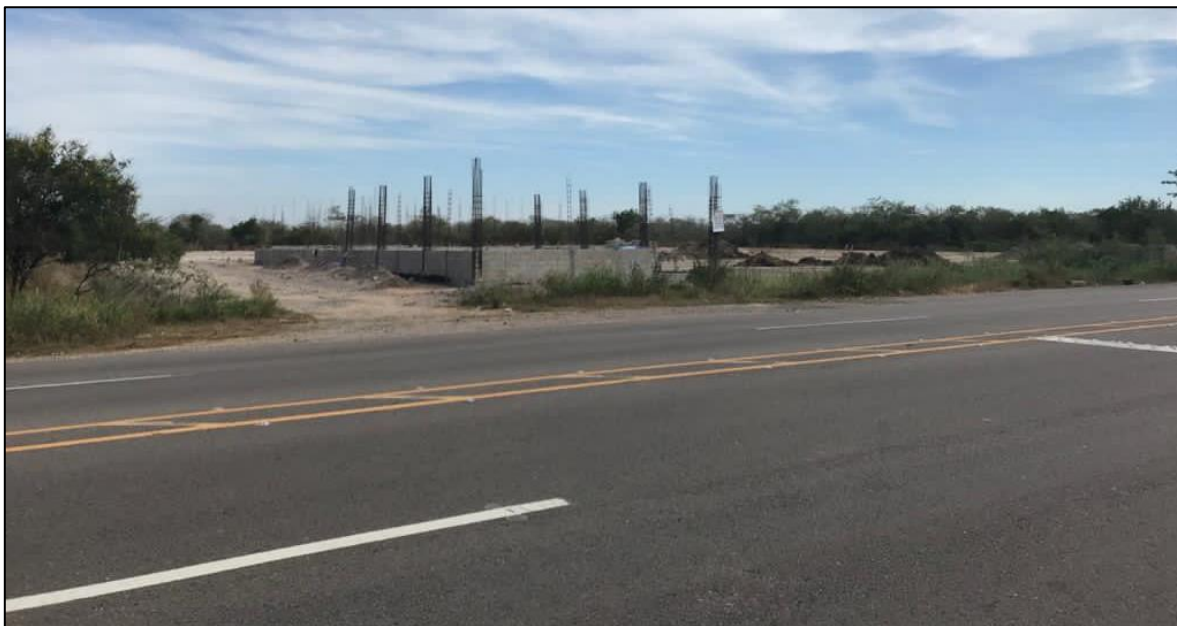
Fotografía 13.- Vista panorámica actual del proyecto.
