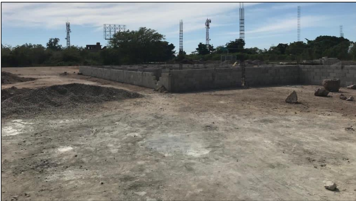
Fotografía 18.- Avance en la infraestructura del proyecto.
