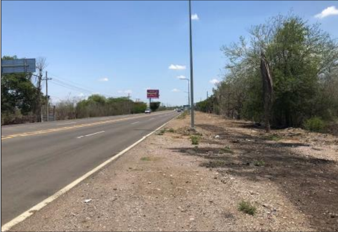
Fotografía 11.- Vista de la principal vía de comunicación (carretera camino al aeropuerto) desde el predio del proyecto
