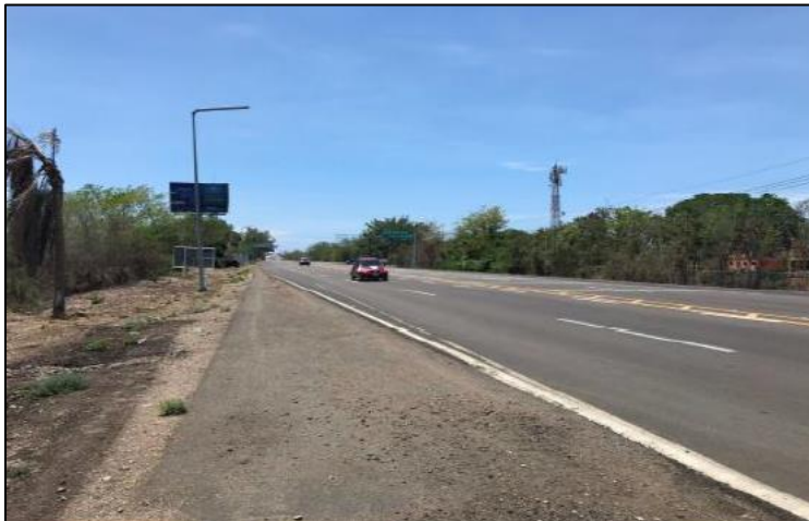
Fotografía 1.- Carretera colindante al poniente
