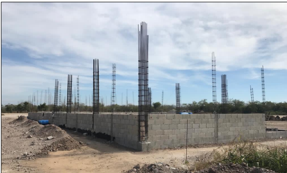
Fotografía 14.- Vista actual del avance en la construcción de estructura de tienda de conveniencia y locales comerciales.
