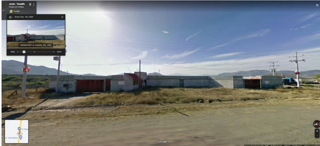
Figura 8. Vista de la construcción hasta el año 2009 dejada por el dueño anterior, el predio fue adquirido por la empresa Gas de Provincia S.A. de C.V. en el año 2010.
