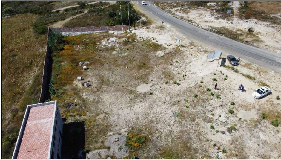
Fotografía 7. Imagen aérea, donde se muestra parte de la barda ya construida en las colindancias sureste y suroeste del predio.
