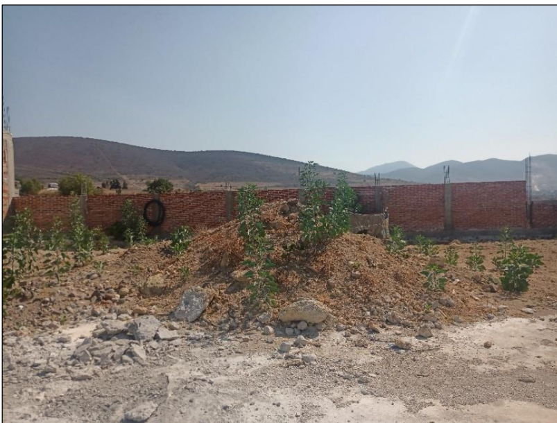
Fotografía 3. Costado noreste del predio, donde ya existe barda y una construcción en obra negra.
