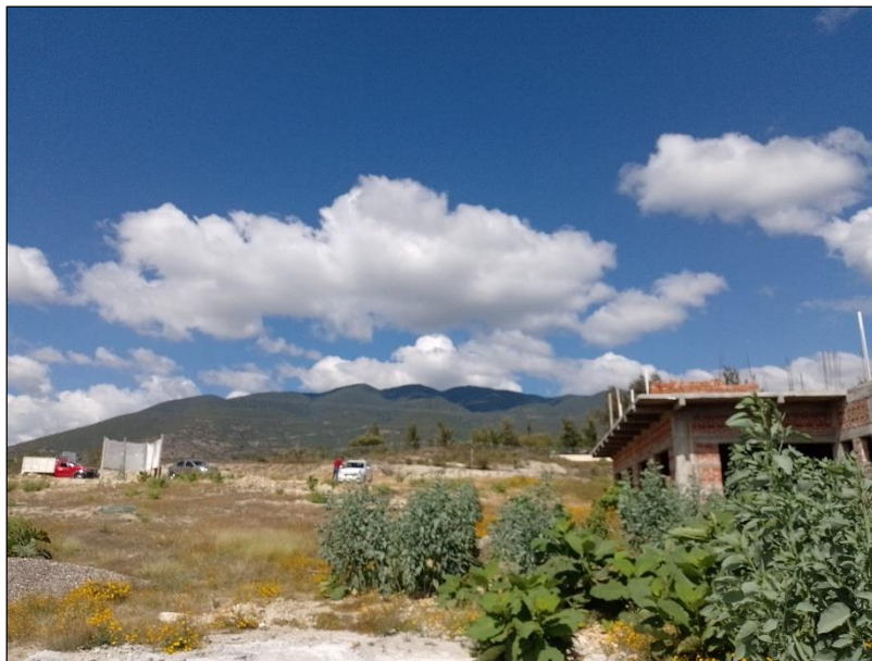
Fotografía 20. Tomada del vértice 4 hacia los vértices 2 y 3, donde se puede observar la construcción ya que será habilitada como locales comerciales y parador.
