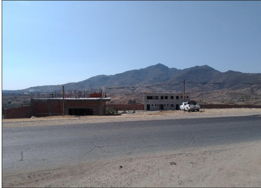
Fotografía 1. Costado norte del predio, el cual servirá como acceso a la estación de servicio.
