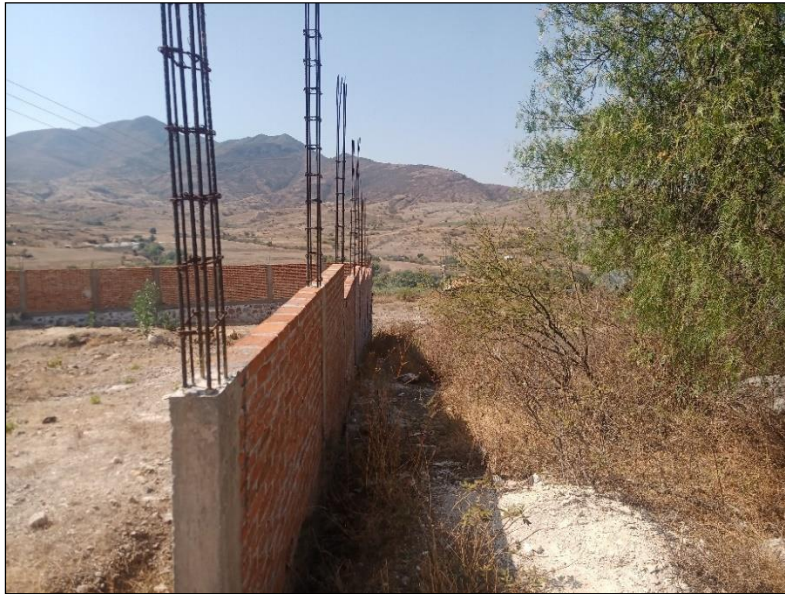
Fotografía 36. Nótese las condiciones actuales de la colindancia suroeste.
