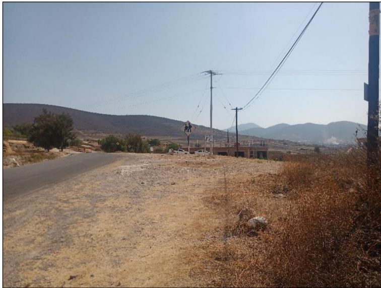
Fotografía 38. El predio donde se pretende construirla la Estación de Servicio colinda al Noroeste con la Carretera estatal San Dionisio Ocoteppec-Ocotlán de Morelos, dirección Ocotlán de Morelos el cual servirá como acceso principal a la estación de servicio.
