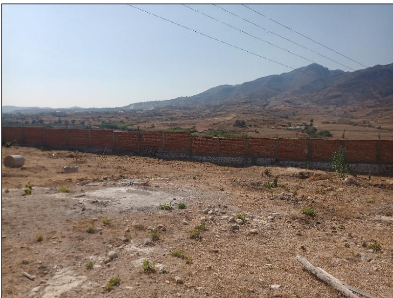
Fotografía 4. Costado sureste del predio, donde ya existe barda perimetral.
