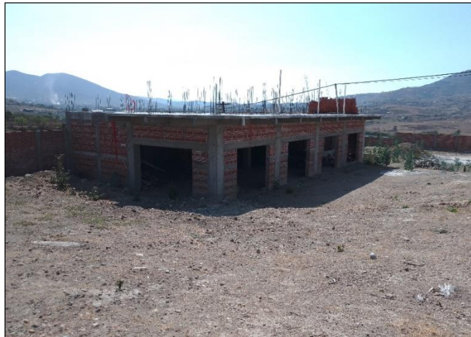
Fotografía 11. Construcción en obra negra ya existente en el predio la cual será habilitado para locales comerciales en la parte baja (ya construida) y paradero en la parte alta, falta por construir.
