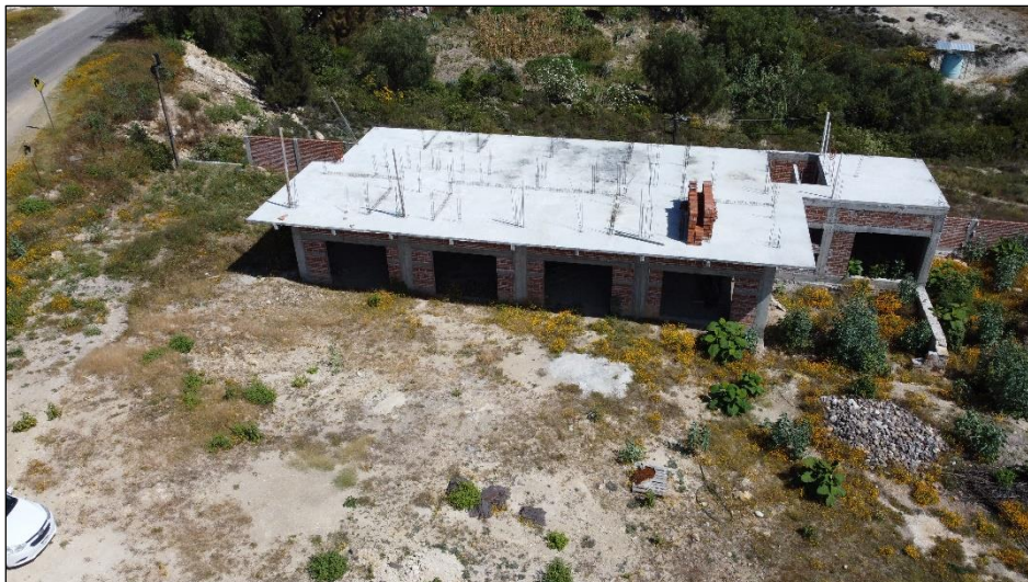
Fotografía 10. Imagen aérea, donde se muestra parte el edificio en obra negra que será utilizado como locales comerciales y parador, ubicado en la parte noreste del predio.
