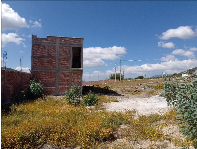
Fotografía 19. Tomada del vértice 4 hacia los vértices 5 y 6, donde se puede observar la construcción ya que será habilitada como edificio administrativo, así como la barda perimetral en el costado suroeste.
