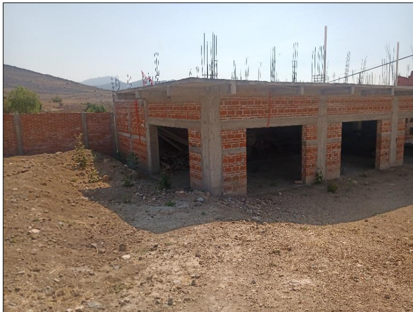
Fotografía 2. Costado noreste del predio, donde ya existe barda y una construcción en obra negra.
