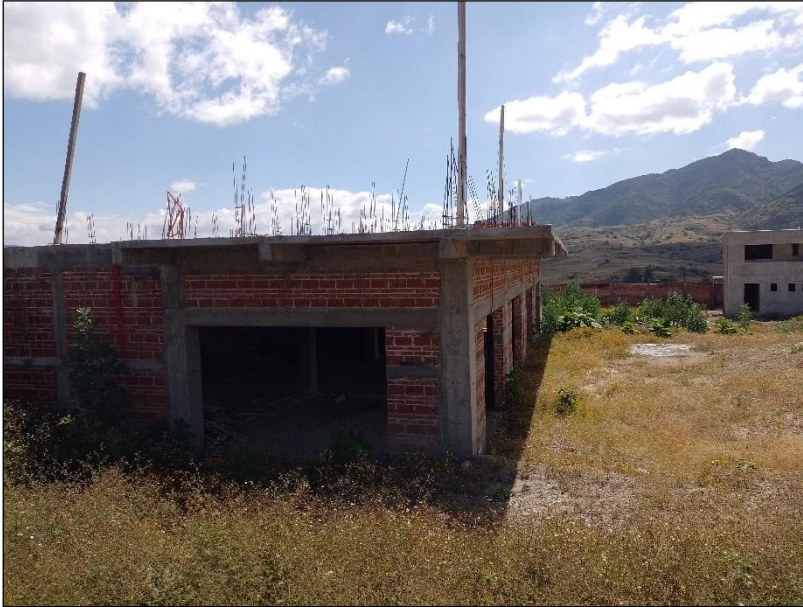
Fotografía 17. Tomada del vértice 3 hacia los vértices 4 y 6, donde se puede observar las construcciones ya existentes así como la barda.
