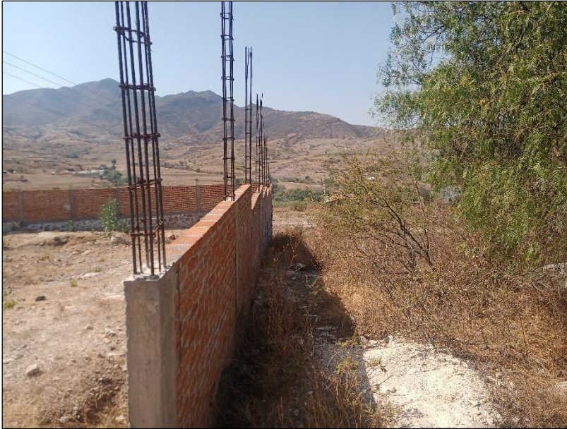
Fotografía 5. Costado suroeste del predio, donde ya existe barda perimetral.
