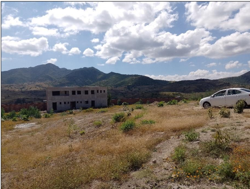
Fotografía 18. Tomada del vértice 3 hacia los vértices 5 y 6, donde se puede observar la construcción ya que será habilitada como edificio administrativo, así como la barda perimetral.
