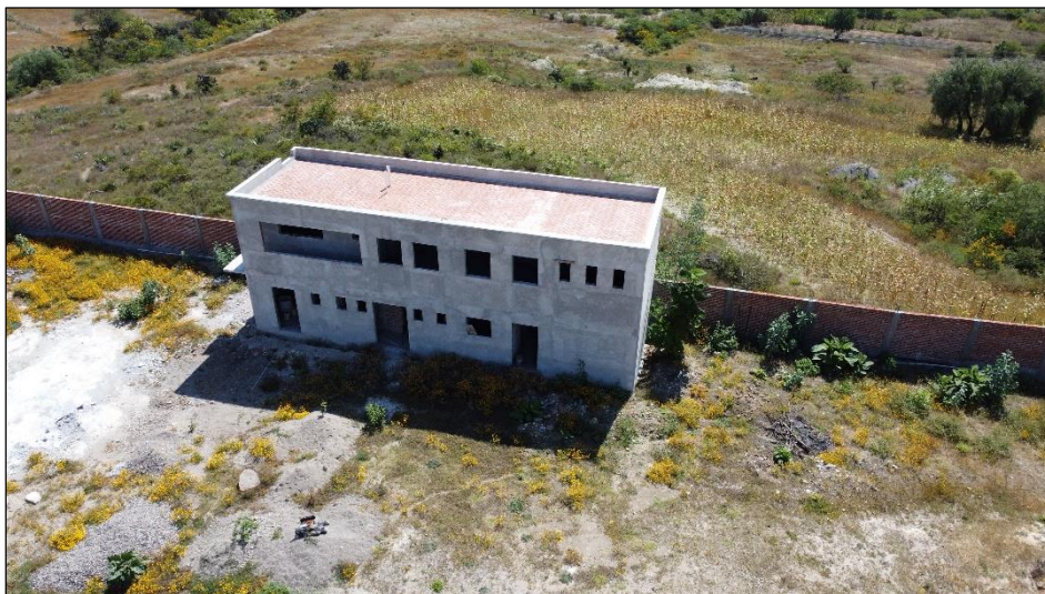
Fotografía 8. Imagen aérea, donde se muestra el edificio en obra negra de dos plantas que será utilizado como edificio administrativo, ubicado en la parte sureste del predio.
