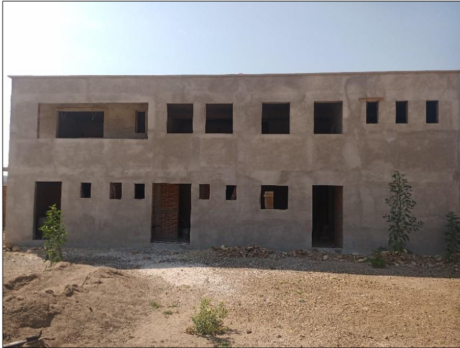
Fotografía 9. Construcción en obra negra ya existente en el predio la cual será habilitado como edificio de servicios.
