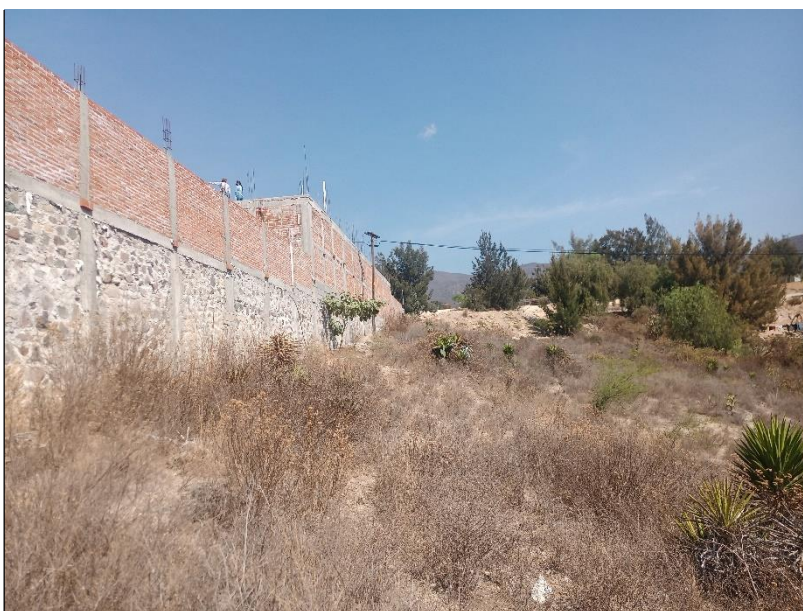
Fotografía 35. Condiciones actuales de la colindancia del predio en la parte Noreste.
