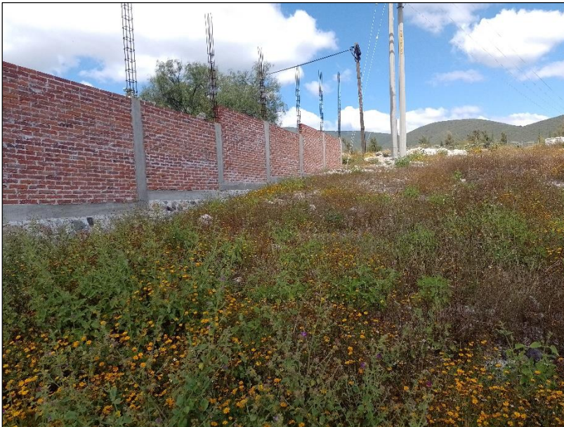
Fotografía 22. Tomada del vértice 6 hacia el vértice 1 donde se puede observar la barda perimetral en el costado suroeste del predio.
