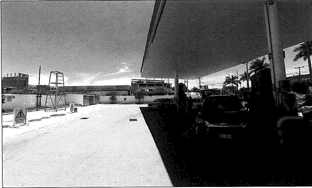
Imagen 11. Vista del Interior de la Estación de Servicio.
