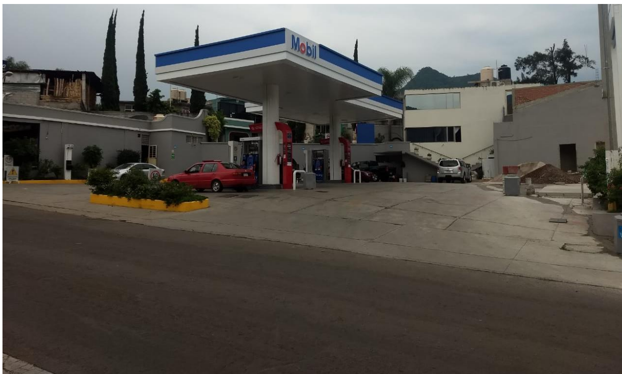
Figura 26. Zona actual de la estación de servicio Jungapeo
