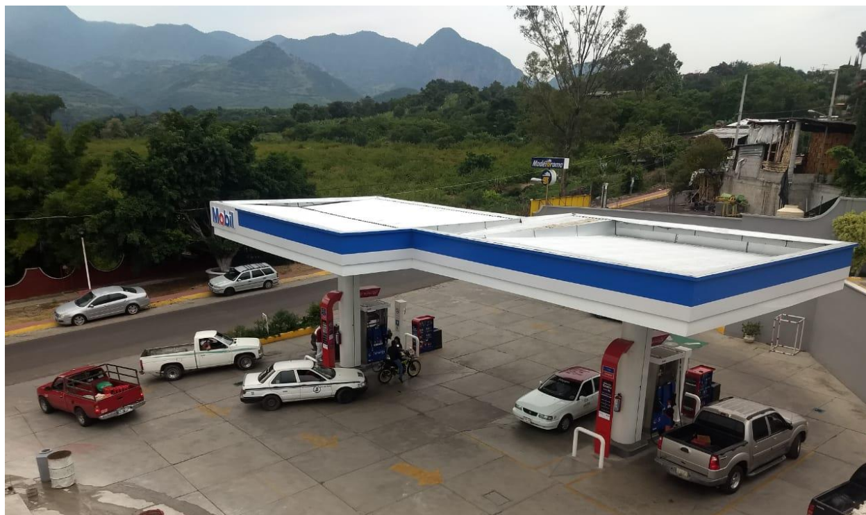
Figura 15. Zona agropecuaria vista hacia el frente de la estación.
