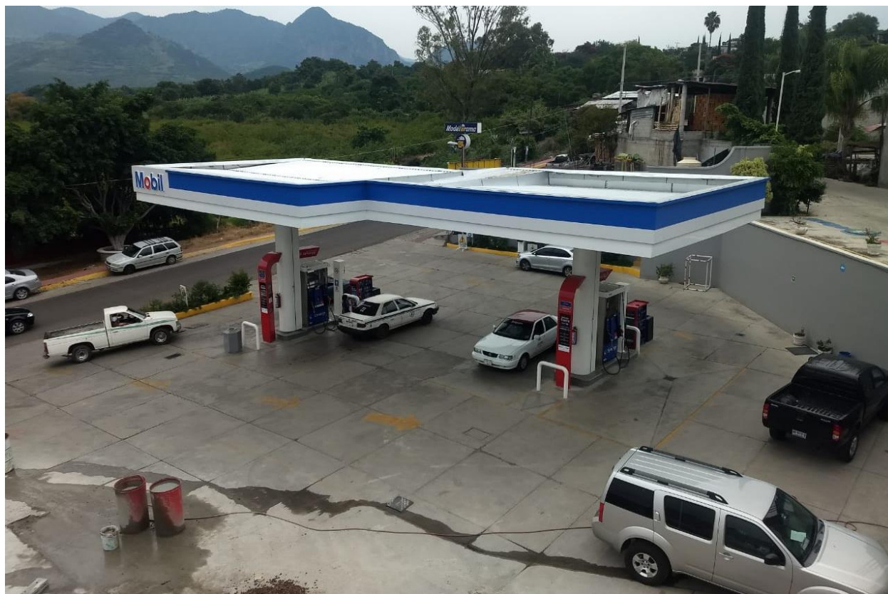
Figura 27. Vista hacia el Este de la estación en donde se ubican huertas de aguacate y guayaba.
