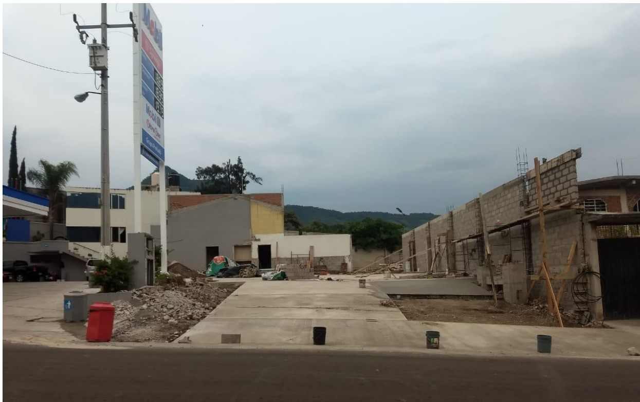
Figura 25. Vista de frente a la gasolinera Jungapeo, en donde se modernizara mediante el aumento del número de dispensarios.
