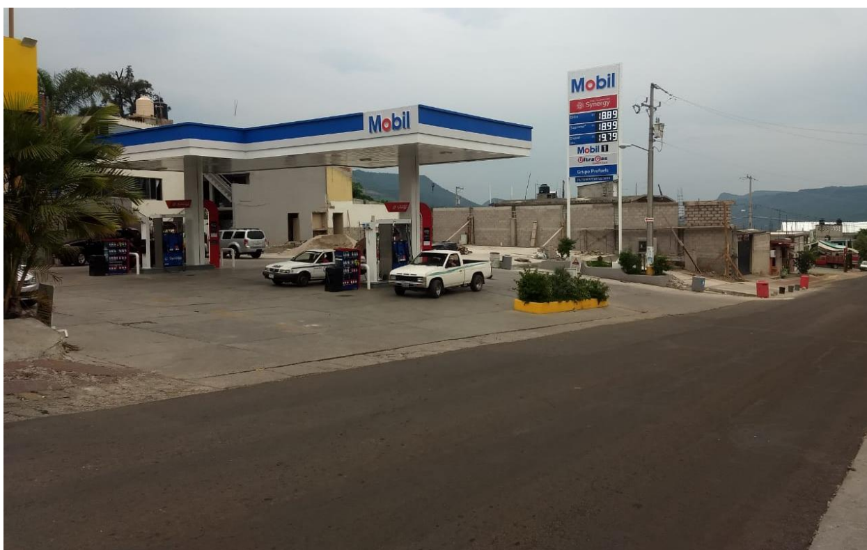
Figura 14. Estación de servicio Jungapeo sobre la Av. Revolución
