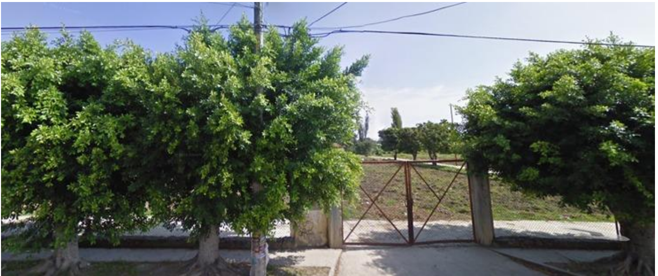
Ilustración 22 Vista del acceso al predio
