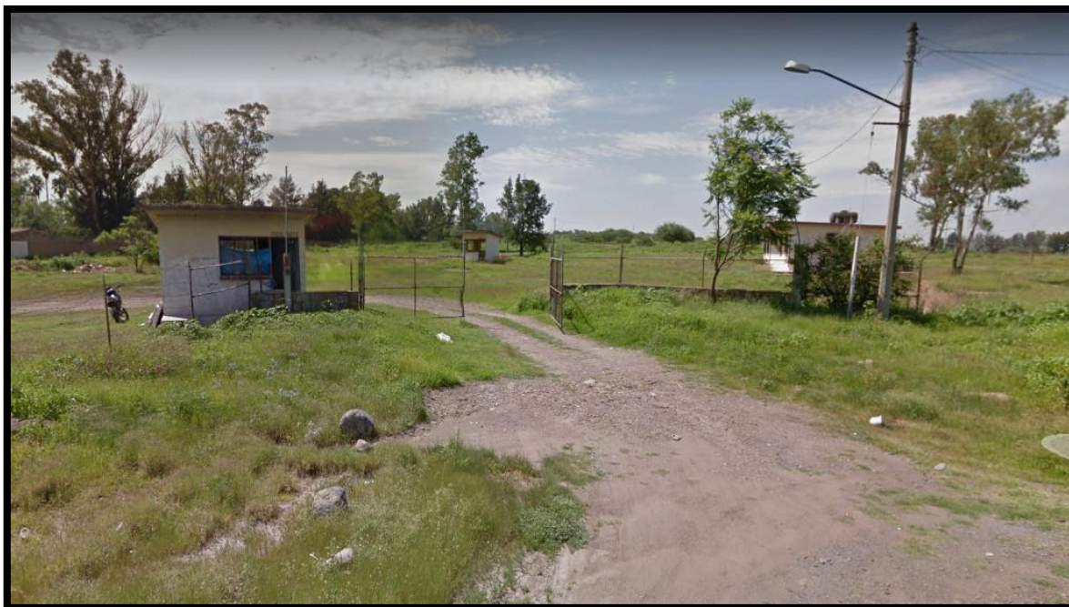
Fotografía 3 Vista del predio del proyecto y edificaciones a demoler
