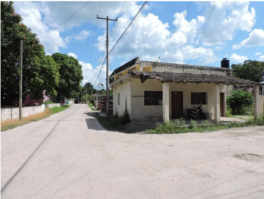
B7.-Vista hacia el este, se observa la calle 9 de Pisté, postes de distribución de energía de la CFE y casas habitación.
