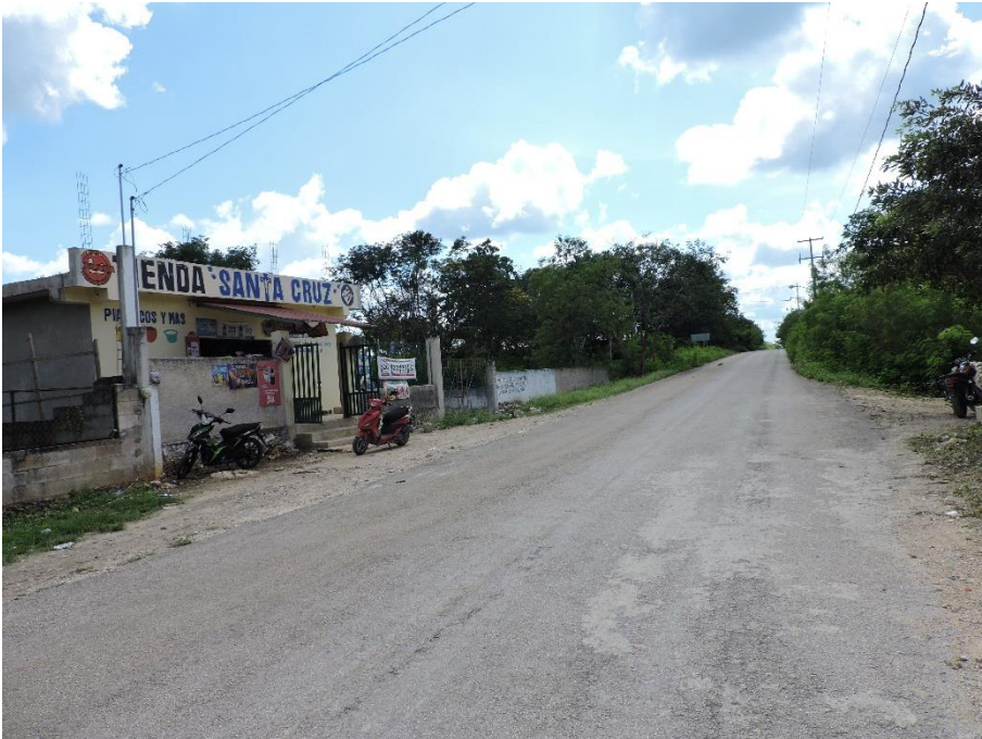
E16.-Vista hacia el sur, se observa la tienda “Santa Cruz” de Pisté y la calle 22.
