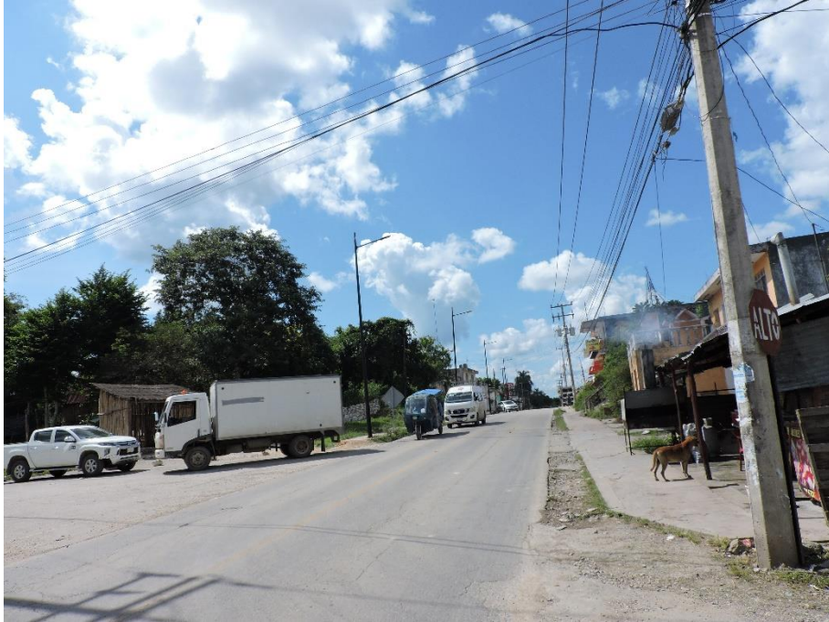
C11.-Vista hacia el oeste, se observa la carretera Mérida-Valladolid, comercios particulares y casas habitación.
