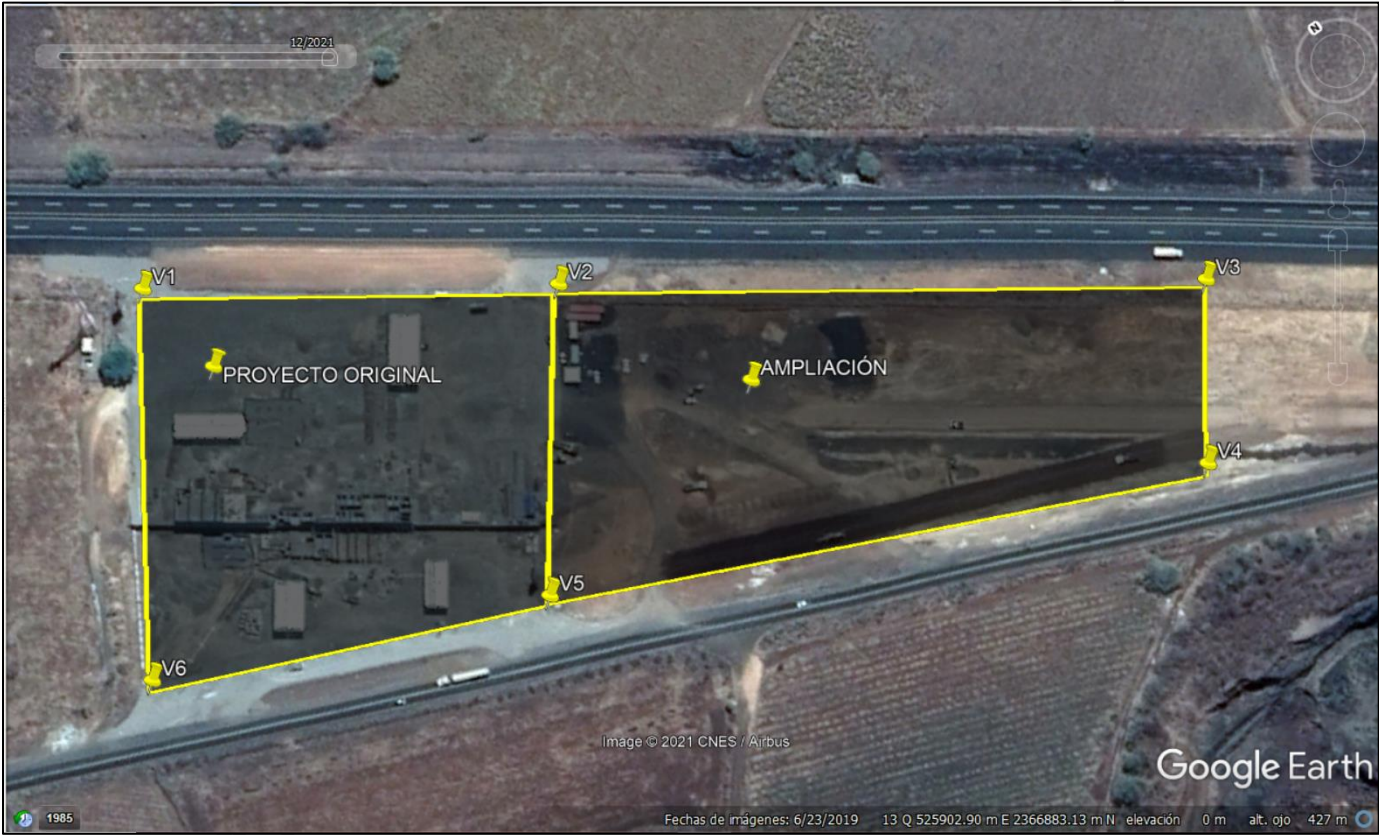
Imagen satelital de la ubicación de las instalaciones PROYECTO MODIFICADO
