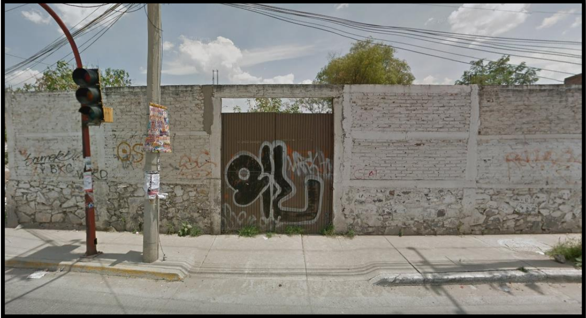
FOTOGRAFÍA 25. SITIO DEL PROYECTO.
