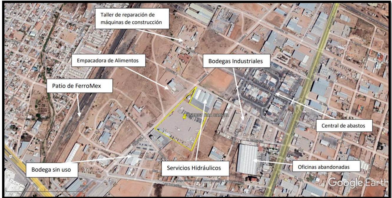
Actividades dentro de la zona industrial y en la zona del proyecto
