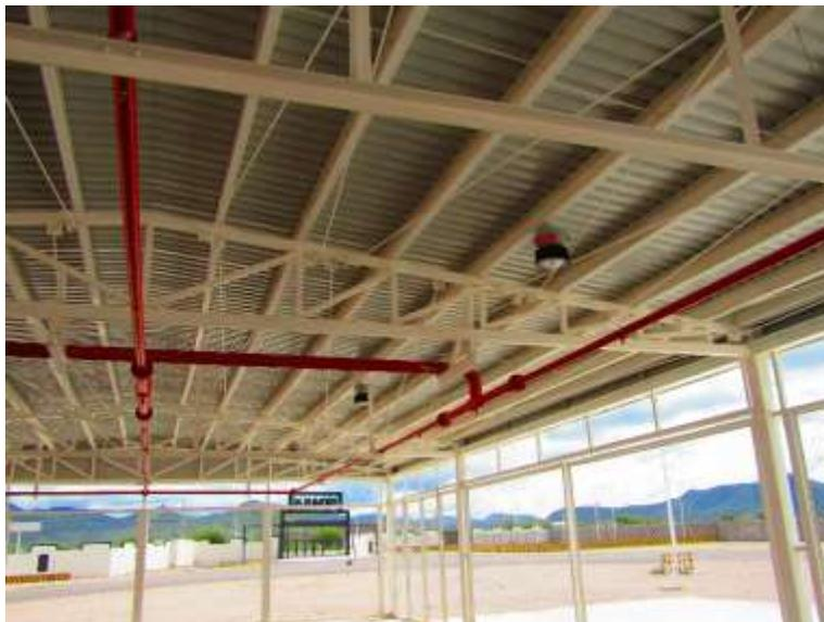
Figura IV. 12. Sistema de aspersión del muelle de llenado.
