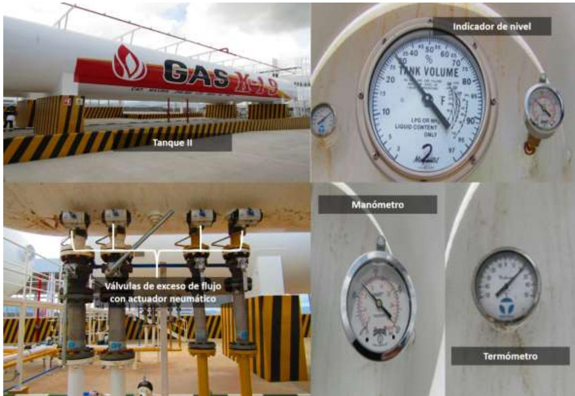
Figura IV. 3. Accesorios del tanque II.
