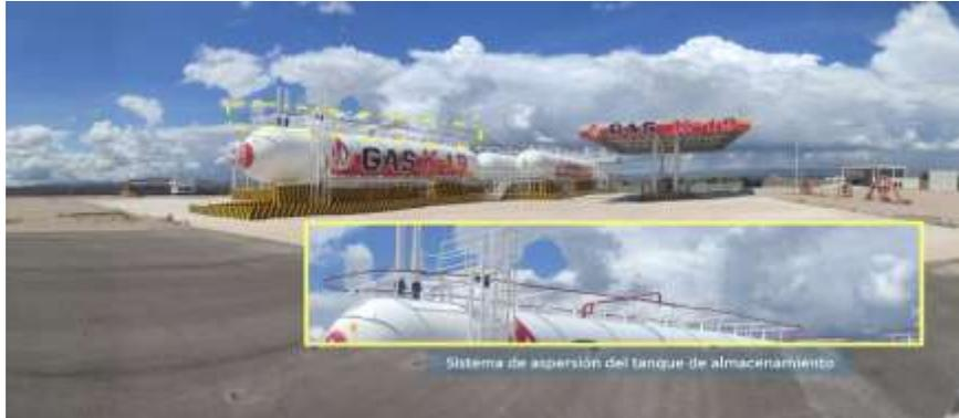
**Figura IV. 5.** Sistema de aspersión en los tanques de almacenamiento.
