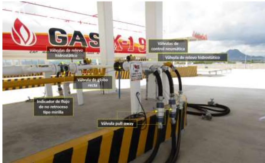
**Figura IV. 6.** Equipo en la toma de recepción de la Planta de Distribución de Gas L.P.
