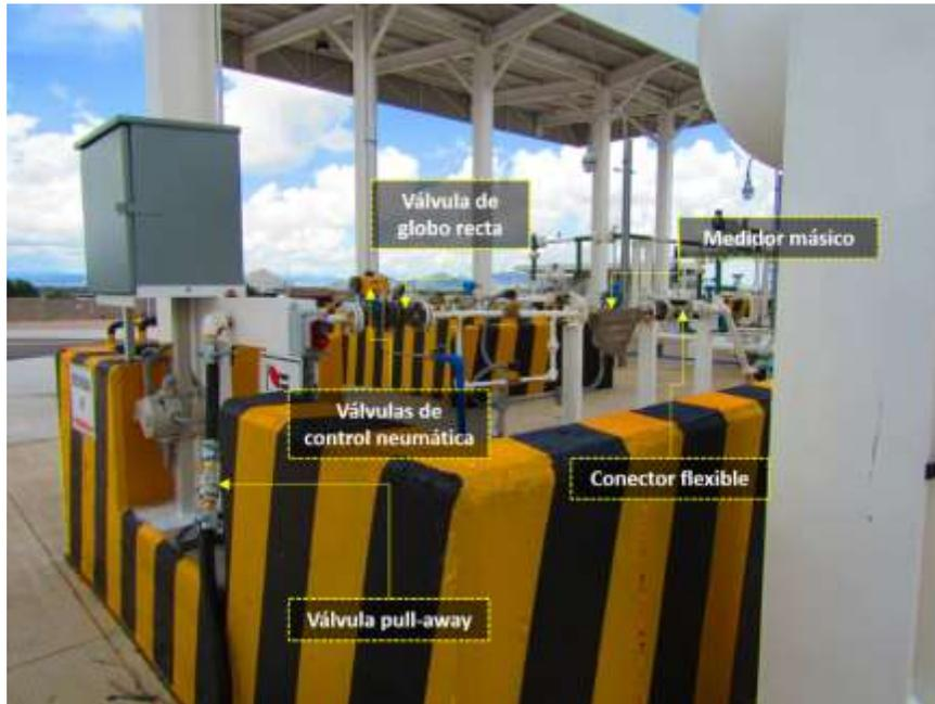
**Figura IV.8.** Equipo en la toma de autoconsumo de la Planta de Distribución de Gas L.P.
