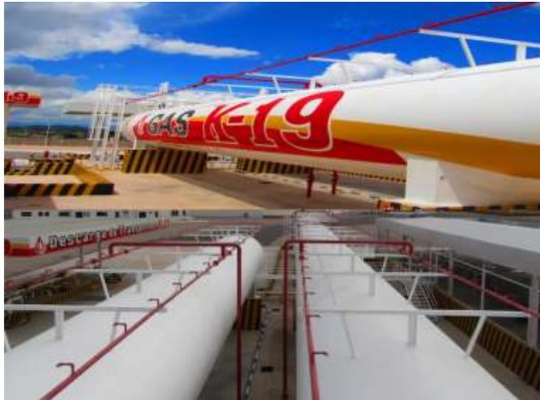
Figura IV. 11. Sistema de aspersión en los tanques de almacenamiento.
