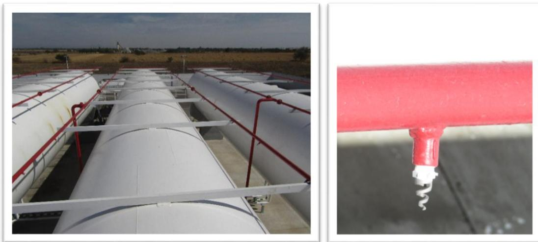
**Figura IV.2.** Sistema de enfriamiento por aspersión de tanques de almacenamiento.
