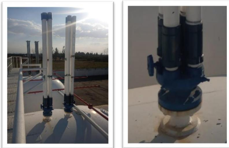
**Figura IV.1.** Aditamentos múltiples de tanques de almacenamiento.
