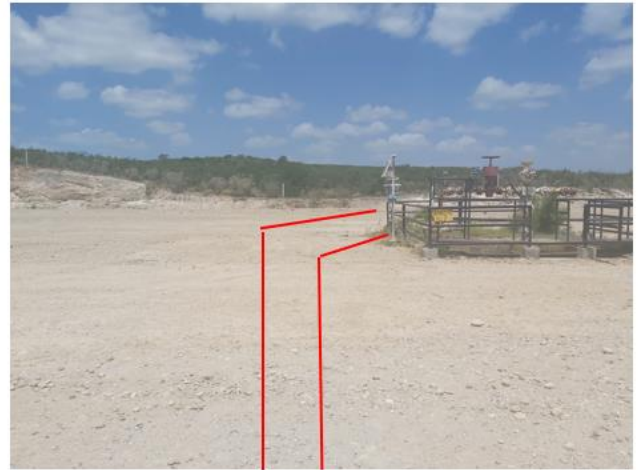
Figura 29 Se observa en fotografía a la izquierda con vista al Oeste de la macropera, el cual inicia el trazo de la LDD desde Granaditas-9DES con destino a la bajante de producción del pozo existente Granaditas-7 que se observa al fondo de las fotografías.
