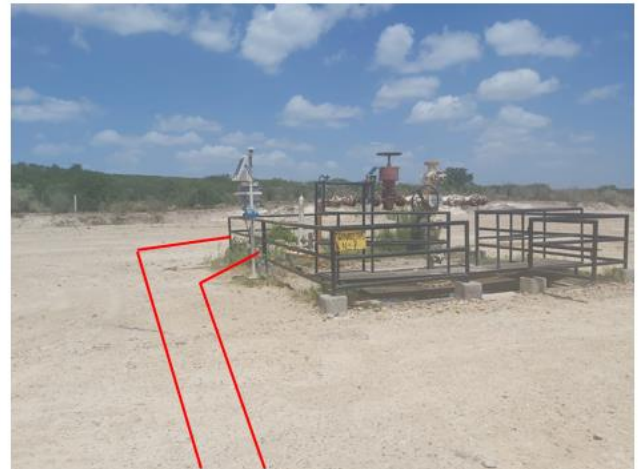
Figura 30 Se observa en fotografías con vista al Oeste de la macropera, la cual se observa el trazo de la LDD en línea recta, posterior hace pequeño punto de inflexión a la derecha y así conectarse a la bajante de producción del pozo existente Granaditas-7 que se observa en las fotografías.
