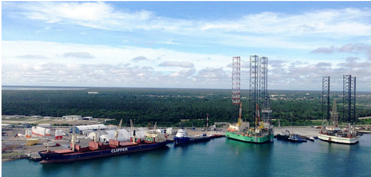
Figura 2.2. Puerto de Dos Bocas.
