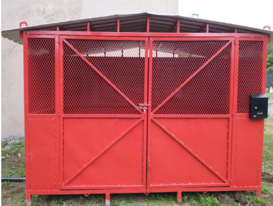
Figura 10. Almacén temporal de residuos peligrosos en las instalaciones
