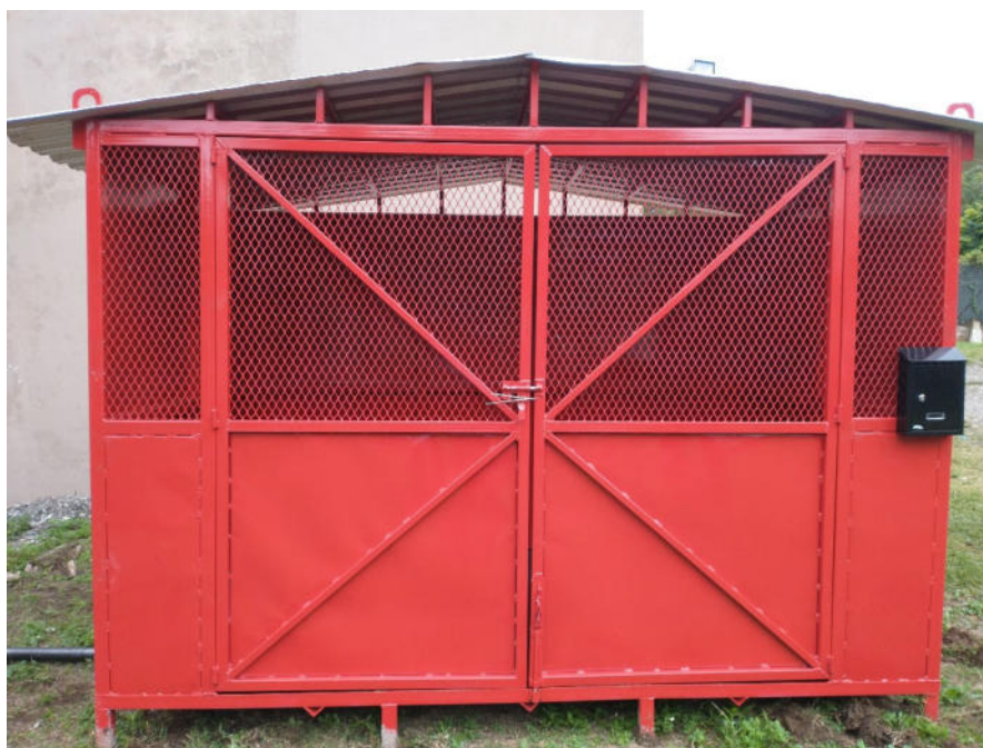
Figura 10. Almacén temporal de residuos peligrosos en las instalaciones
