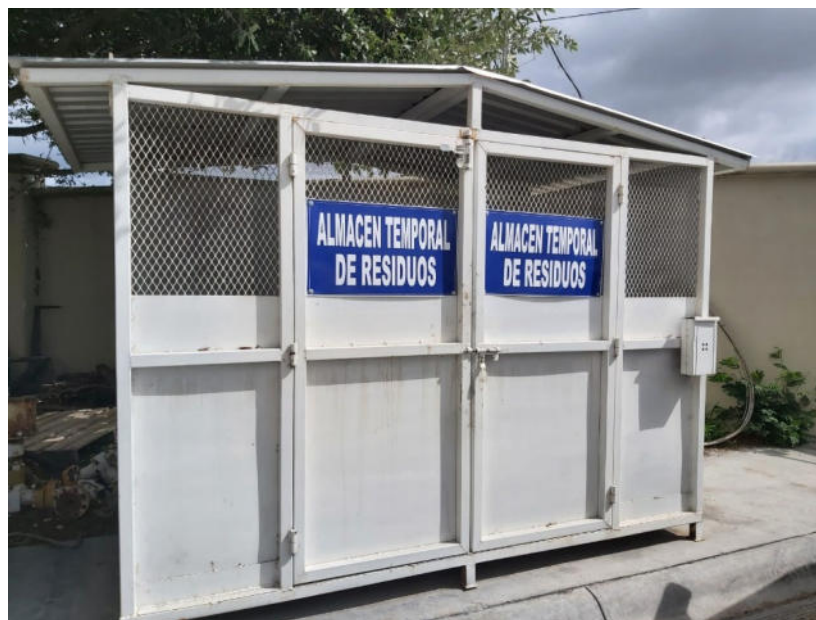
Figura 10. Instalación del almacén temporal de residuos peligrosos
