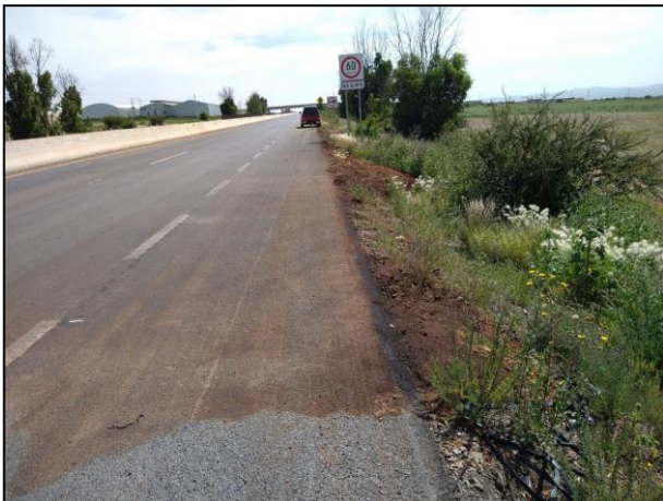
03. Área Afectada por el derrame de Diésel (Fosa de Excavación "B").
