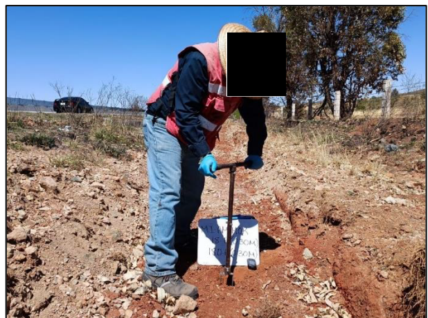
06. Toma de muestra en fondo de la Fosa de Excavación "A".
