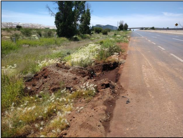
01. Punto de impacto ubicado en el Km. 002 + 400 de la Carretera 2673 Ruta 54 Zacatecas – Saltillo, municipio de Morelos, estado de Zacatecas.
