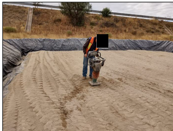
11. Con apoyo de vibro compactador manual se compactó la capa de arcilla.
