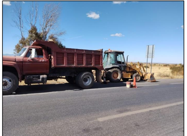
16. Depósito de material extraído en camión de volteo.
