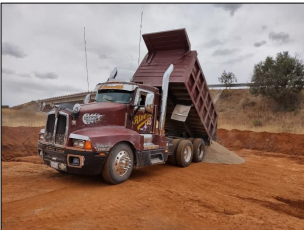
05. Con apoyo de camión de volteo se colocó una capa de arcilla sobre la base de la celda provisional.
