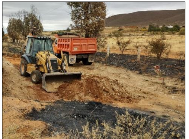
12. Con apoyo de retroexcavadora se realizaron las actividades de extracción en el sitio, originando la Fosa de Excavación "A".
