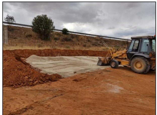
06. Con apoyo de retroexcavadora se distribuyó la capa de arcilla sobre la base de la celda.
