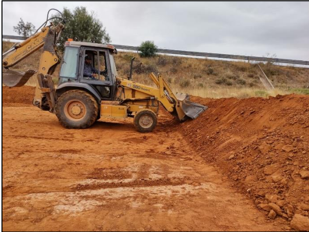
03. Compactación de bordos perimetrales con apoyo de retroexcavadora.
