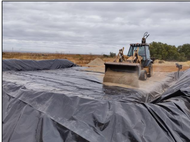
09. Se colocó una segunda capa de arcilla por encima de la película de polietileno de alta densidad.
