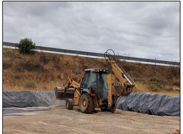
10. Con apoyo de retroexcavadora se distribuyó la segunda capa de arcilla.
