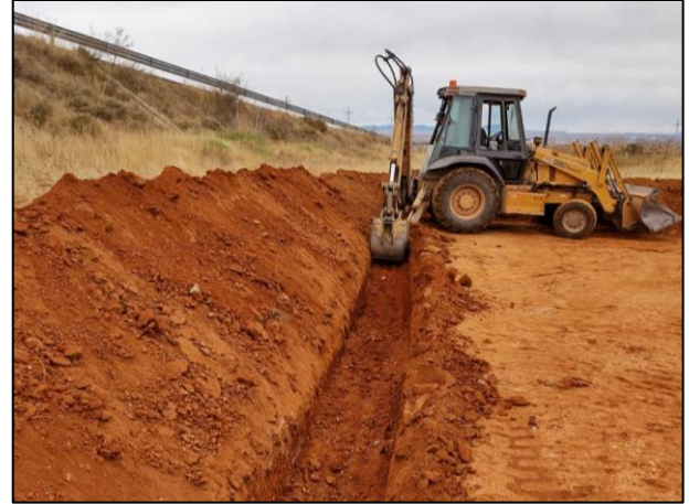
04. Construcción de canaletas de captación de lixiviados.
