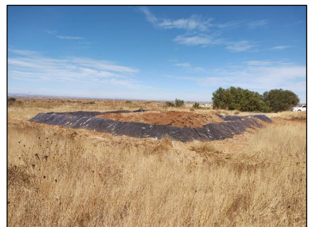
24. El material edáfico afectado con Diésel fue depositado en la celda provisional.
