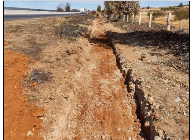
22. Vista general de la Fosa de Excavación "A" (Zona II).
