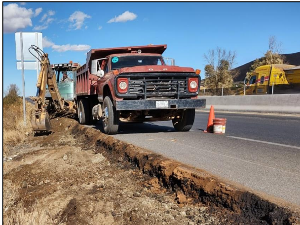
15. Con apoyo de retroexcavadora se realizaron las actividades de extracción en el sitio, originando la Fosa de Excavación "B".
