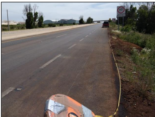
05. Con apoyo de cinta métrica se realizó la medición del Áreas Afectadas correspondiente a la Fosa de Excavación "B".
