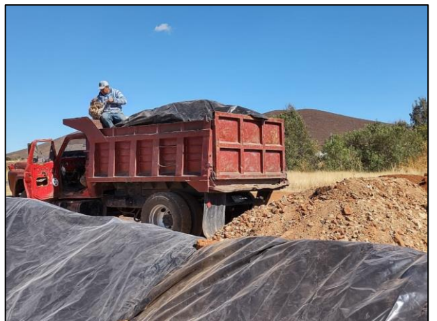
18. El material edáfico afectado fue depositado dentro de la celda provisional con apoyo de camión de volteo.
