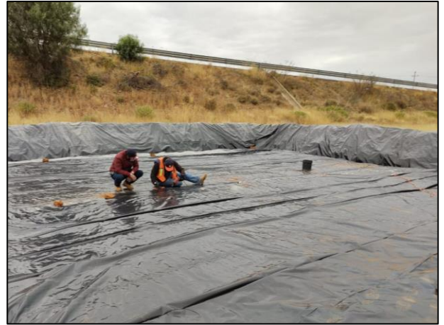
08. Con apoyo de recurso humano la celda provisional se cubrió con una película de polietileno de alta densidad.
