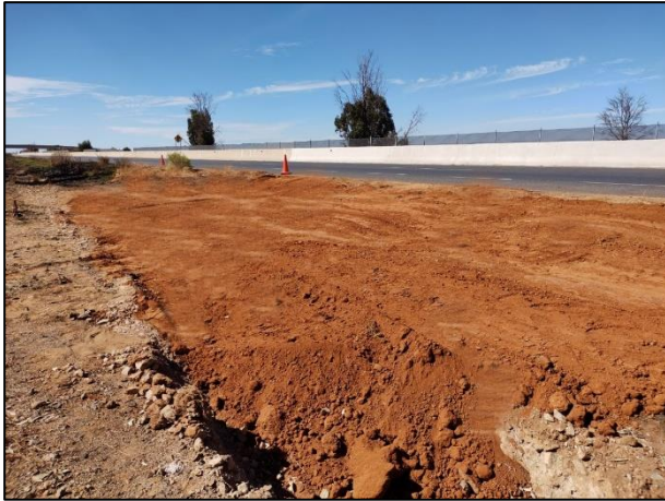
19. La Fosa de Excavación "A" se rellenó parcialmente con material edáfico libre de contaminantes.
