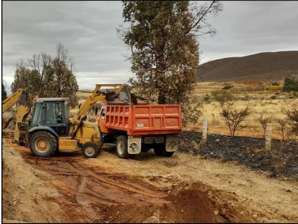
13. El material edáfico extraído fue colocado en camión de volteo para su posterior acarreo hacia la celda provisional.
