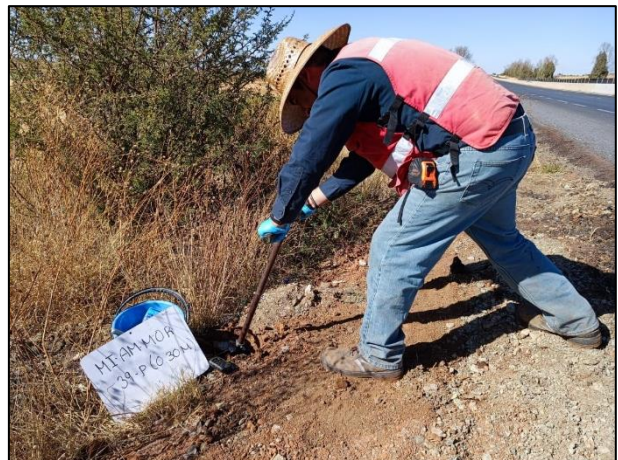
12. Toma de muestras en pared de la Fosa de Excavación "B".
