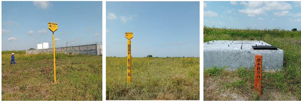
Figura 2.3 Estado actual de los señalamientos donde pasan los ductos.
