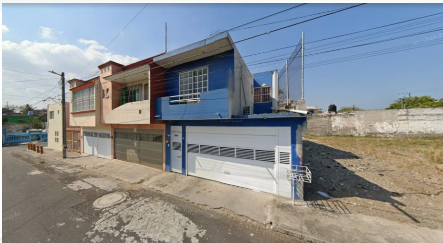
Fotografía 9. Colindancia al oeste del predio del proyecto con casas habitación, ubicadas en la calle Sánchez Tagle.
