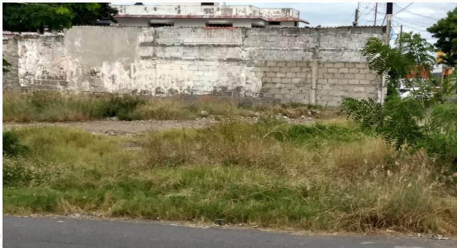
Fotografía 5. Vista del predio del proyecto hacia el la colindancia sur, colinda con barda de casas habitación.
