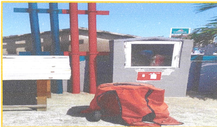
Extintor utilizado para el combate de incendios en la Estación de Servicio No. 1059.
