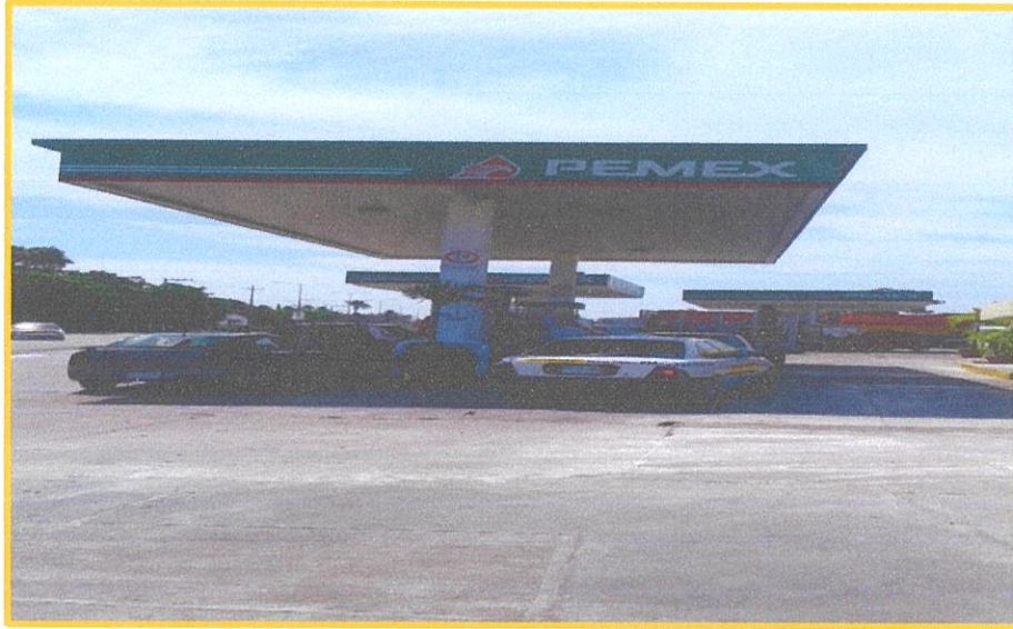
Panorámica de Islas de la Estación de Servicio No. 1059.
