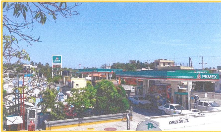
Panorámica desde vista superior de la instalación denominada: "GASOLINERA SERVICIO PARAÍSO S.A. DE C.V."
