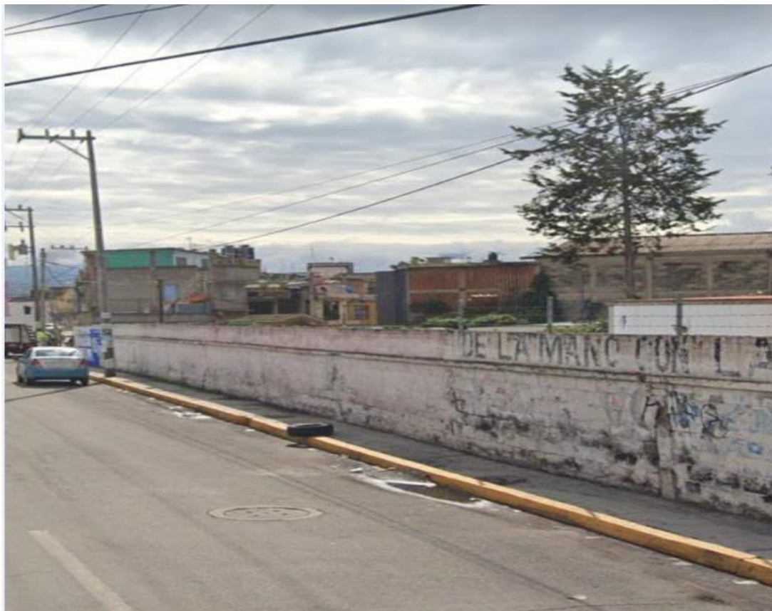
Ilustración 13. Vista del predio colindante con carretera Chalco - Tláhuac
