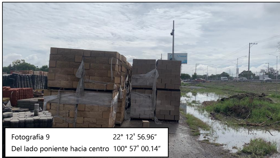
Figura 17.- Fotografía tomada del lado poniente hacia el centro
