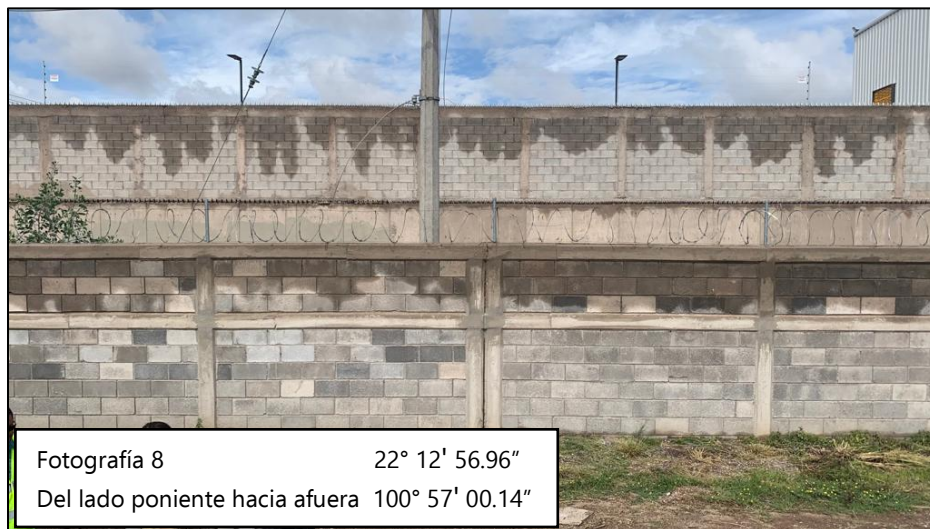
Figura 16.- Fotografía tomada del lado poniente hacia afuera
