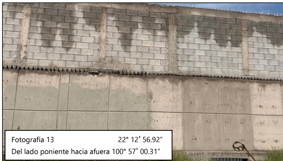
Figura 21.- Fotografía tomada del lado poniente hacia afuera (Tomada desde afuera del predio)
