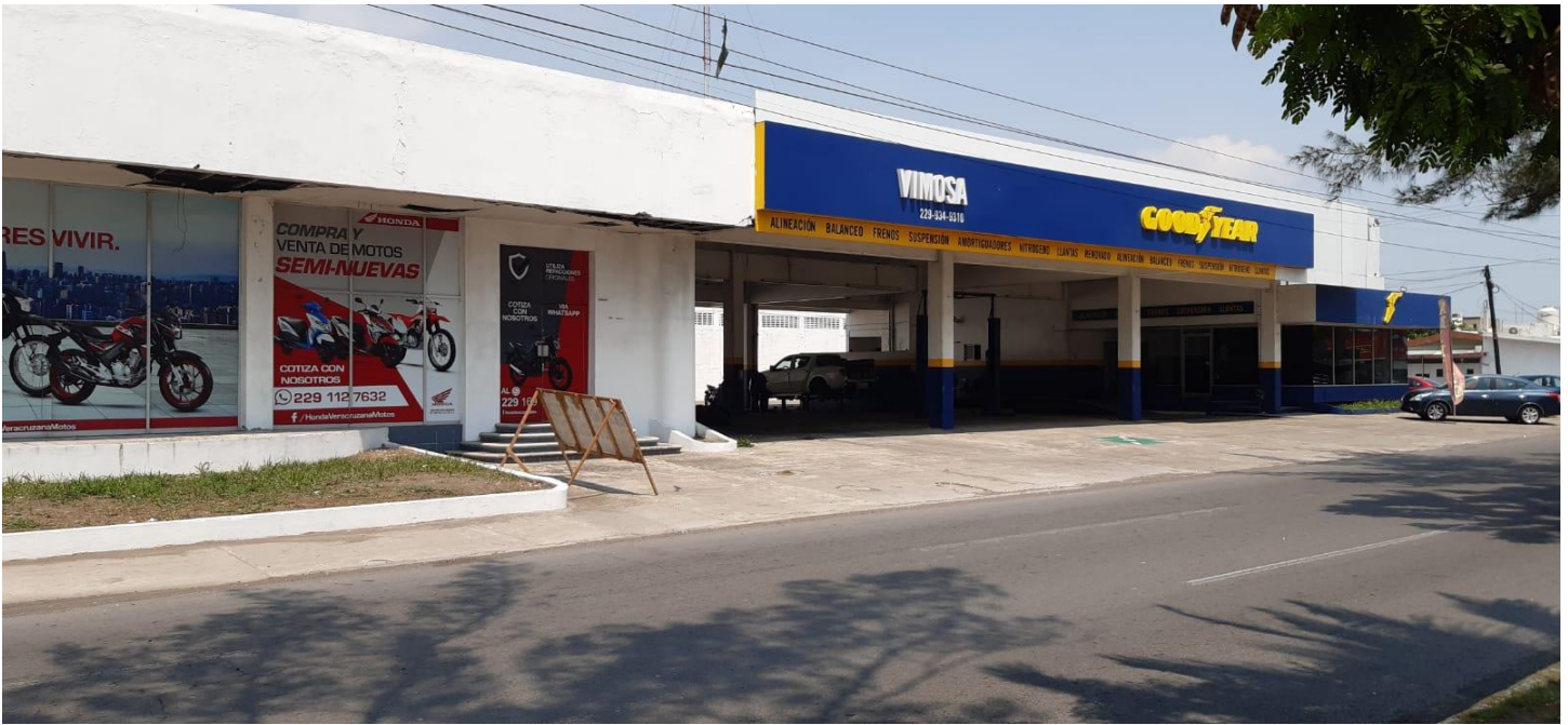
Ilustración 18 Vista frontal del predio y su colindancia con la comercializadora de llantas en la zona norte
