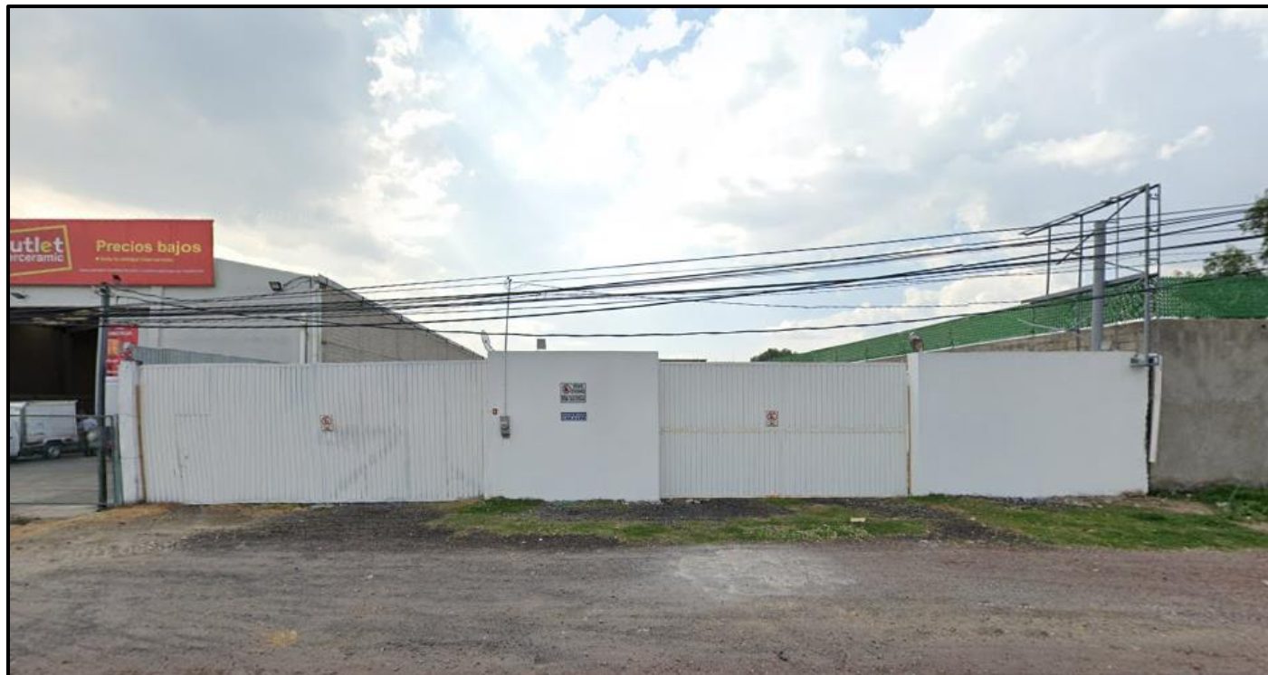
Figura 3. Vista del predio de la Estación de Carburación San Simón.
