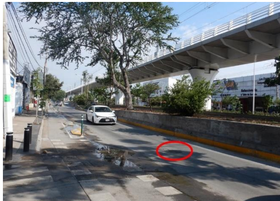
Foto 3-2 Vista de la rejilla de la línea municipal de drenaje y alcantarillado en Av. Juan Pablo II
