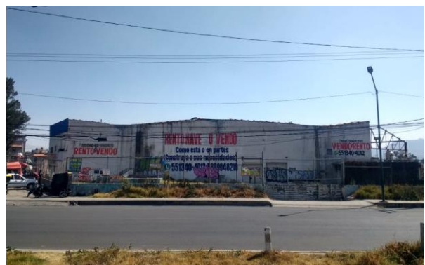
Foto 4- vista frontal del predio. Colindancia Poniente, sobre la Av. Recursos Hidráulicos.
