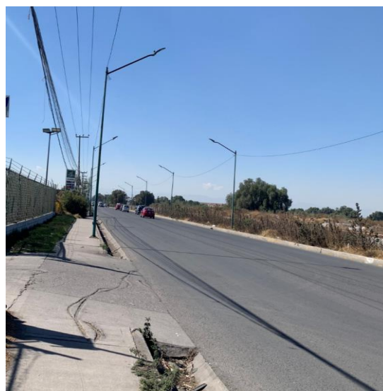
Foto 6- Alumbrado público sobre Av. Recursos Hidráulicos.
