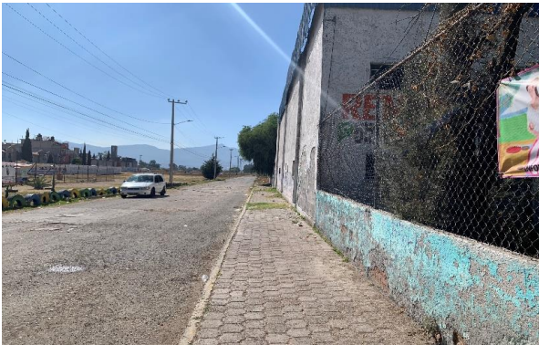
Foto 3- Colindancia Oriente esquina con calle Quintana Roo. Vista en dirección al Sur.
