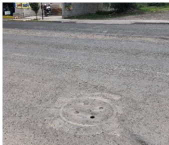
Foto 9- Pozo de visita( drenaje) sobre la Av. Las Ánimas.
