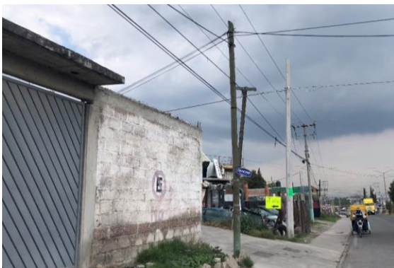
Foto 11- Infraestructura telefónica sobre la Av. Las Ánimas.
