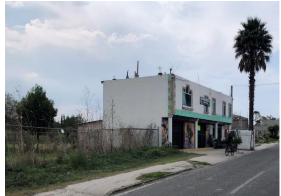
Foto 3- Vista de colindancia Norte, sobre Av. Las Ánimas.
