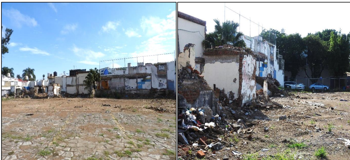
Fotografía 1. y Fotografía 2. Predio para la estación de servicio sin actividades constructivas.
