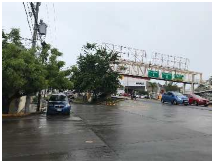
Aspecto general de la zona
