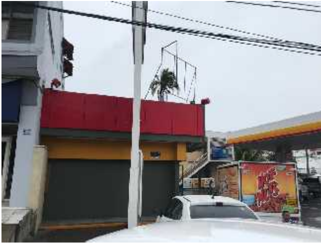
Aspecto del interior de la estación
